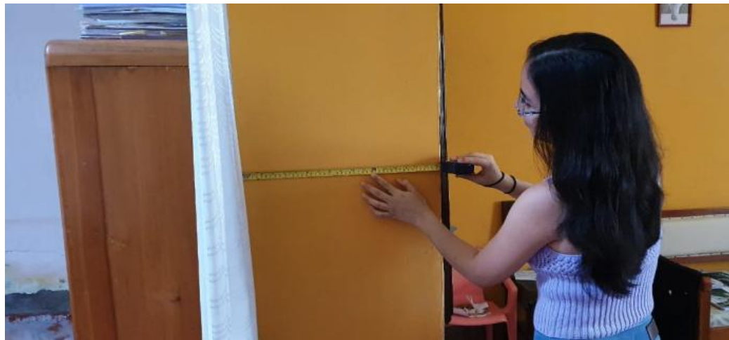
Figura A2.2. Medición de espesor de muro en vivienda de adobe.
