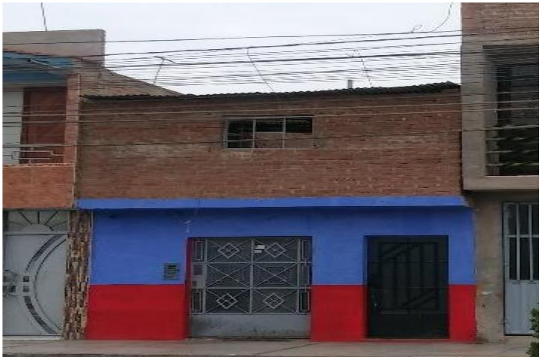
Figura 4.10. Edificación de albañilería con cubierta inestable de material liviano.
