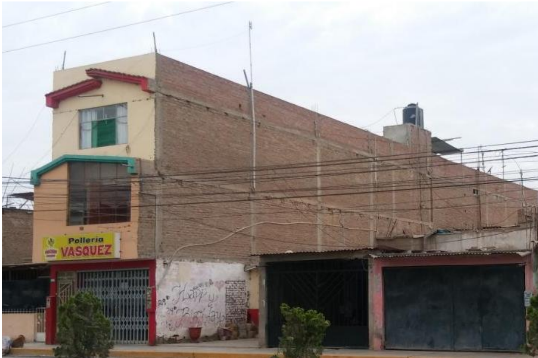
Figura 4.13. Tanque de agua adecuadamente apoyado.
