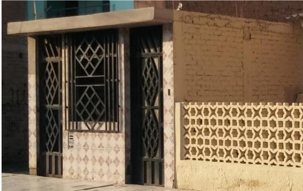
Figura 4.15. Vivienda de albañilería de un nivel. Dirección: Av. 24 de junio Mz. N, Lote 17, Sector 07.
