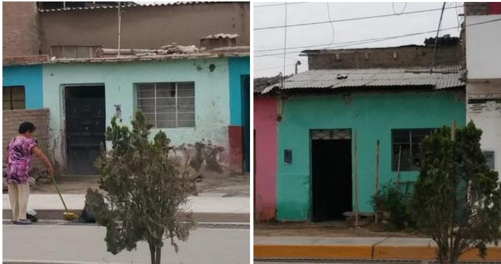
Figura 4.6. Edificaciones de adobe sin presencia de diafragma rígido. Lado izquierdo: techo de torta de barro con vigas de madera. Lado derecho: techo de torta de barro con calamina apoyado en vigas de madera.
