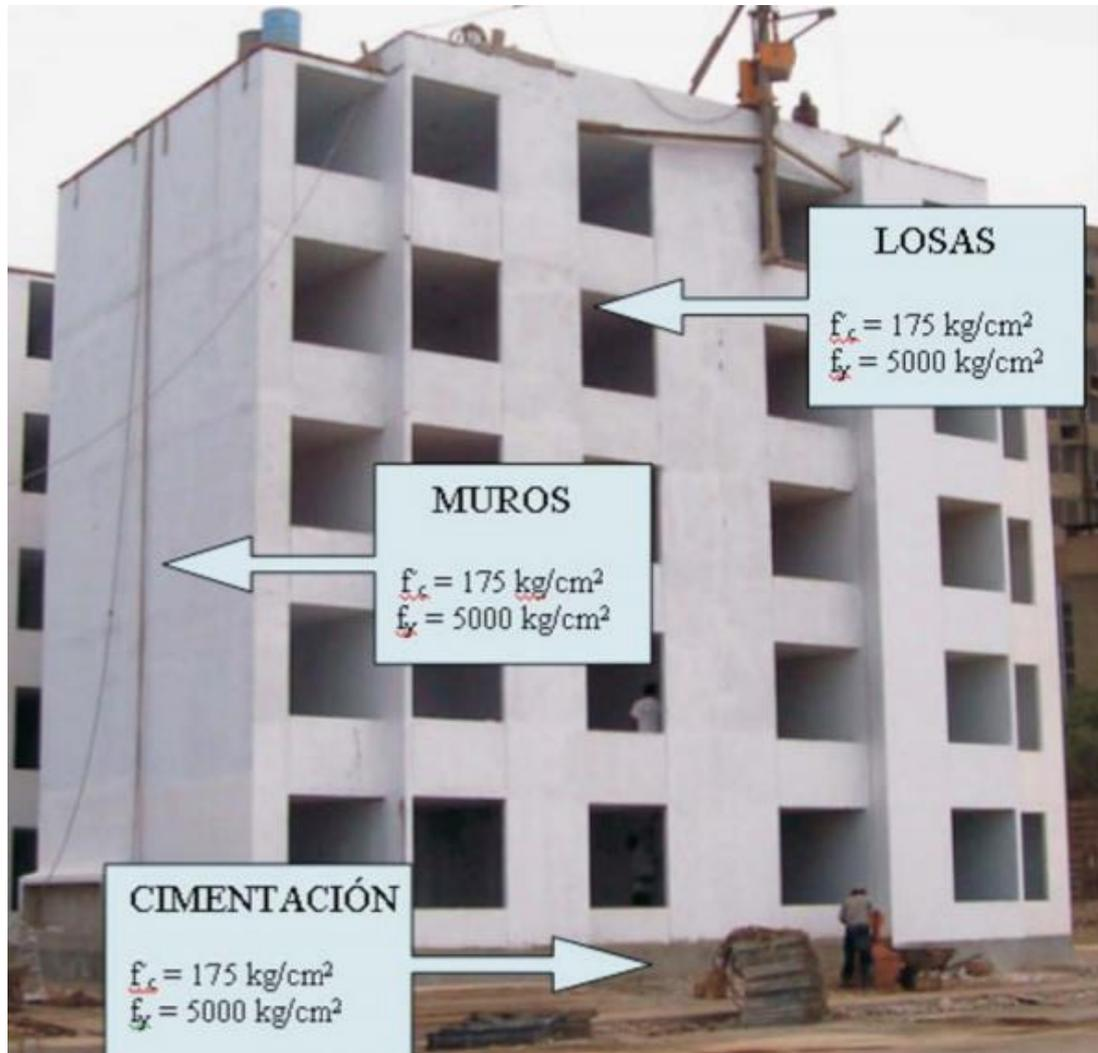
Figura 14. Edificación de muros de ductilidad limitada.
