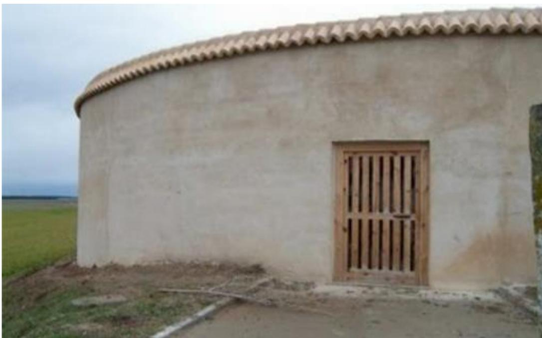
Figura 8. Estructura construida con muros de tapial.
