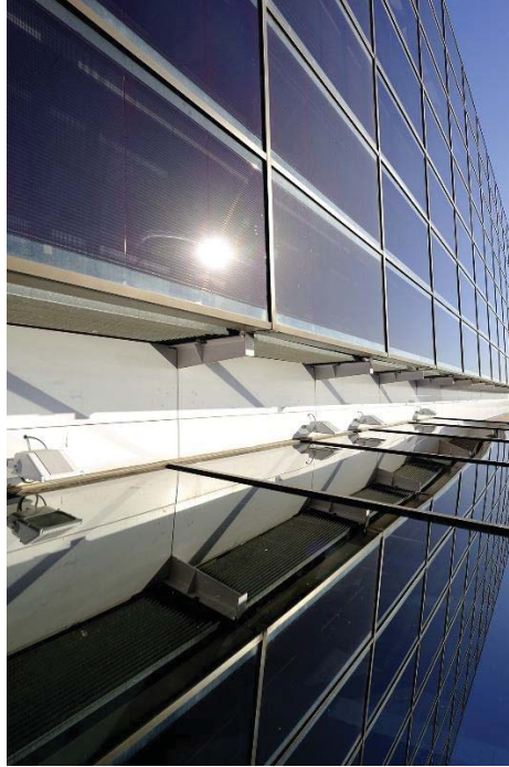
Foto de Panel Fotovoltaico
