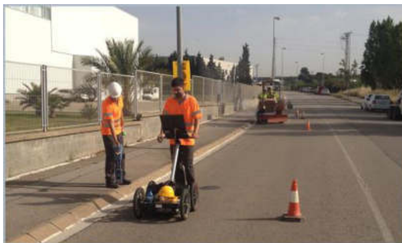
Figura 20. Evaluación estructural del pavimento mediante Georadar
