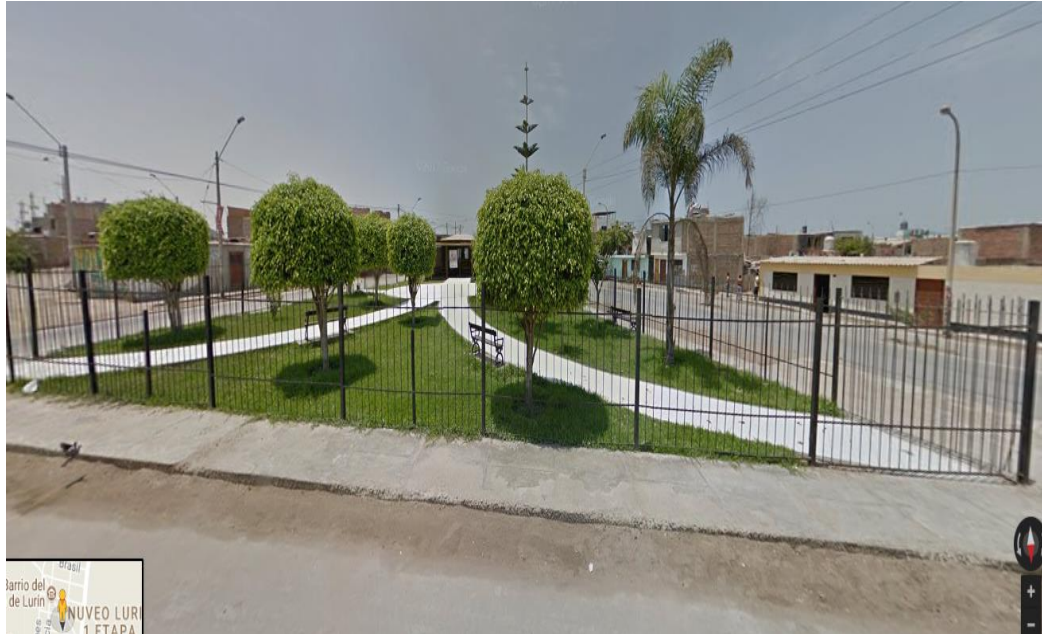
Figura 1. Se puede apreciar, el concepto que se maneja en este único parque en la zona, es de “encerrar” el mismo y así cuidar el parque en cuanto al ornato, las plantas, arbustos, veredas, etc., y la mejor solución es cercarlo con una reja de fierro por todos sus lados.
