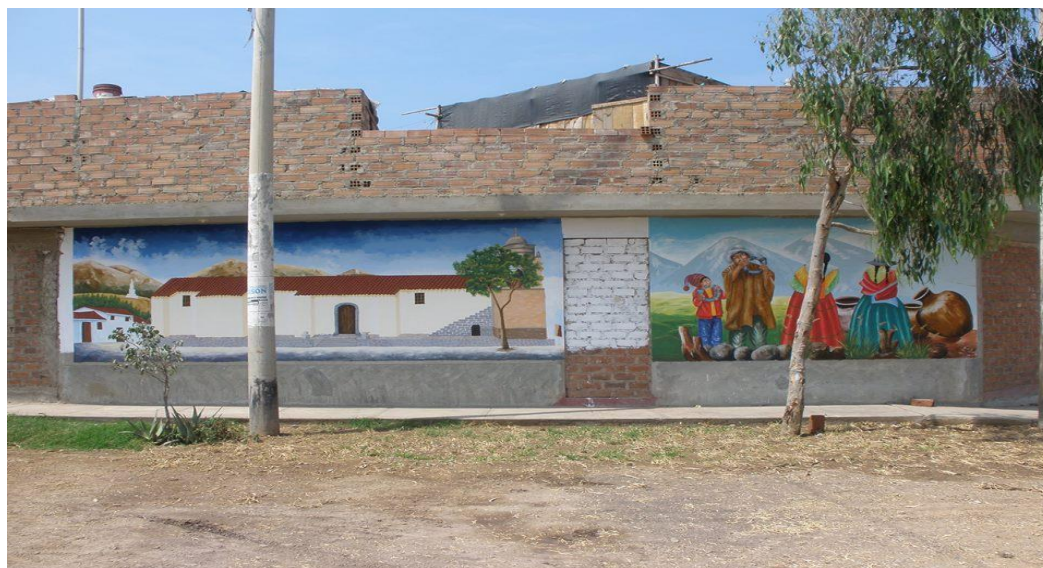
Figura 09 – Fachada terminada en paredes exteriores de casa.
