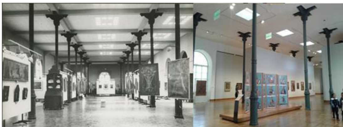
Figura 62 - Vista de columnas en 1966 y 2018
