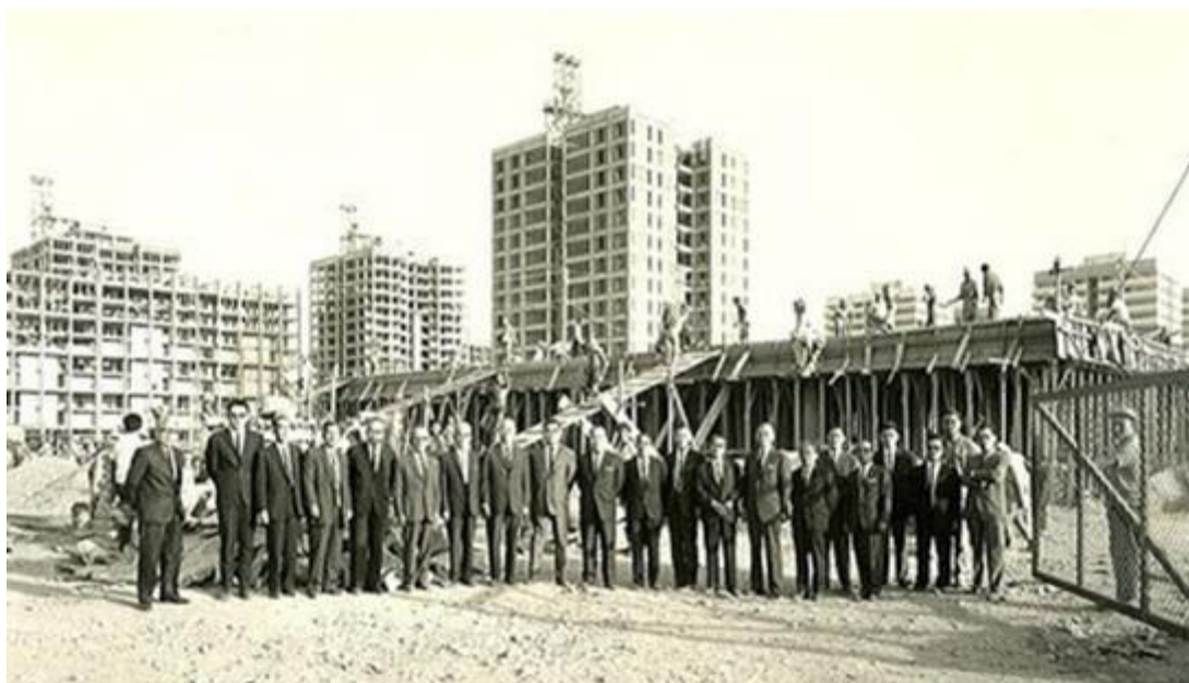
Figura 38 - En 1966, en plena construcción.
