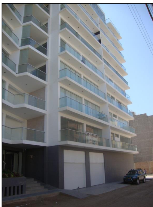
Fig. N° 3.10. Edificación de concreto armado, año de construcción mayor a 1997, materiales de buena calidad y adecuado proceso constructivo. (Calle José Quiñones Cdra. 1)
