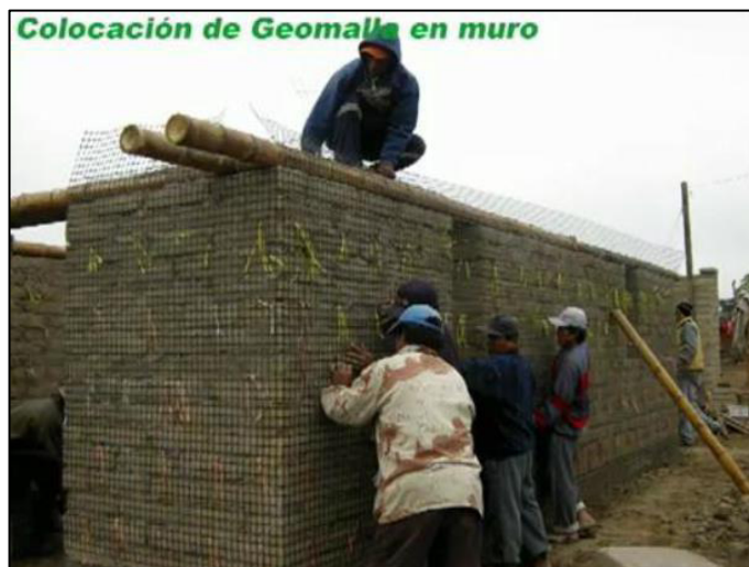
Fig. N°A7.3. Refuerzo de construcciones de adobe con el uso de geomalla sintética.
