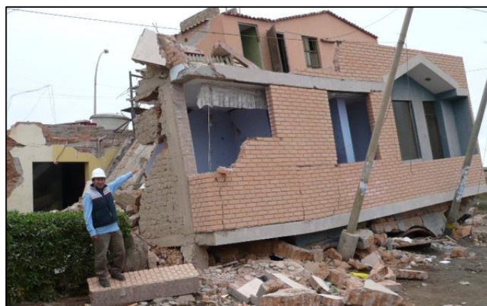
Fig. N° 1.25. Falla por falta de densidad de muros. Pisco, Perú. (San Bartolomé A. 2007)
