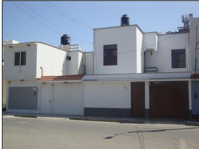
Fig. N° 3.15. Edificaciones de albañilería con esquinas entrantes de menor dimensión en comparación con la longitud total del lote. (Calle Lima Cdra. 1)
