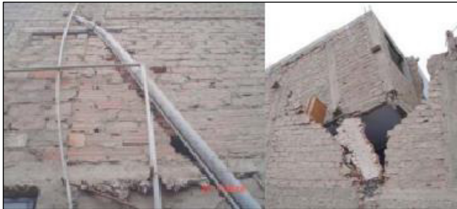
Fig. N° 1.21. Uso de ladrillo pandereta en muro portante. Pisco, Perú. (San Bartolomé A. 2007)
