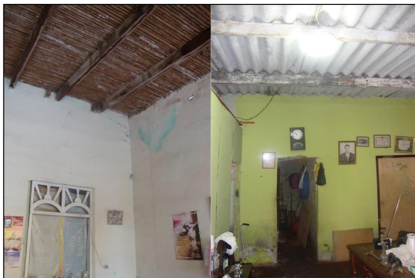
Fig. N° 3.12. Edificaciones de adobe con ausencia de diafragma rígido. Izq.: techo de torta de barro y entramado de vigas de madera. Der: techo de calamina sobre vigas de madera.
