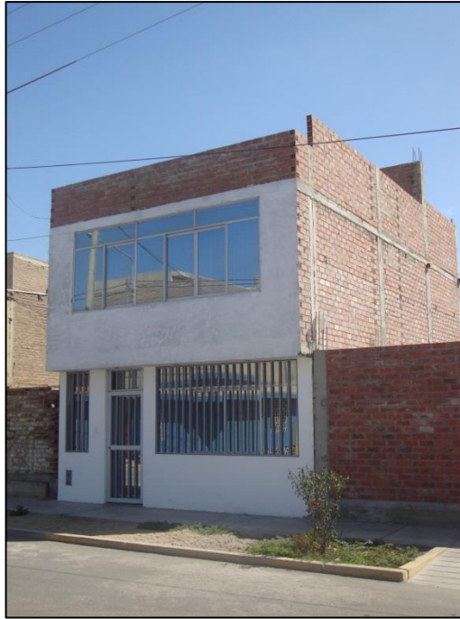
Fig. N° 3.4. Nueva construcción de albañilería, con asesoría técnica, según NTE E.070. (Calle Atahualpa Cdra. 1)
