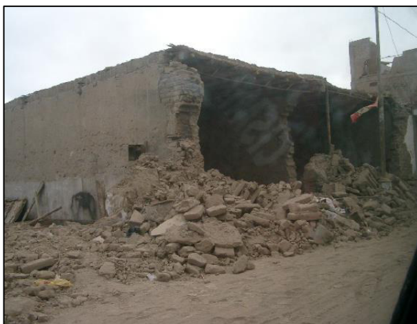
Fig. N° 1.14. Colapso de la fachada, al quedar libre en voladizo. Pisco, Perú. (Kuroiwa J. 2008)
