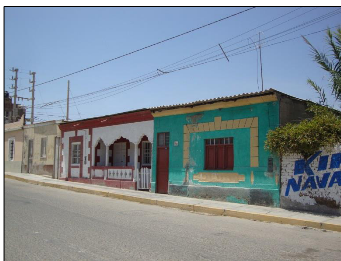
Fig. N° 3.2. Edificaciones de adobe, sin elementos de arrioste en sus cuatro lados pero con adecuada distribución de muros y regularidad. (Calle Chiclayo Cdra. 5)
