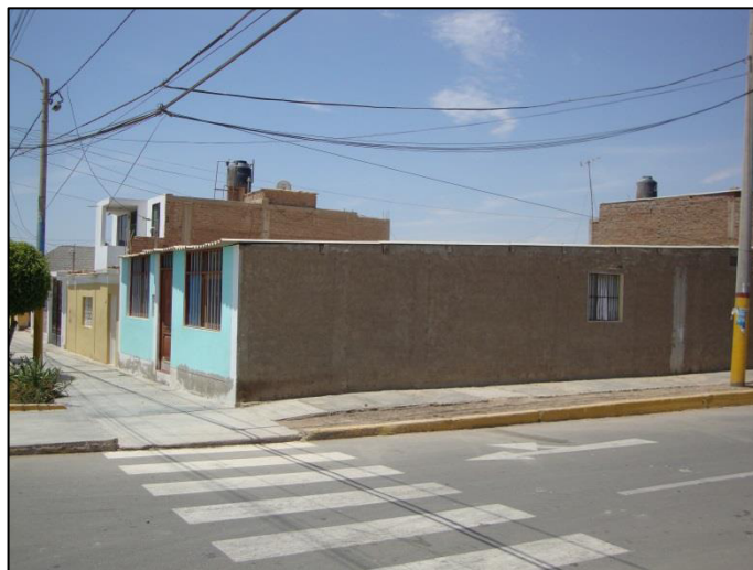
Fig. N° 3.20. Cubierta inestable de calamina (material liviano) en buenas condiciones. (Esquina de Av. Juan Velasco Alvarado con calle César Vallejo)
