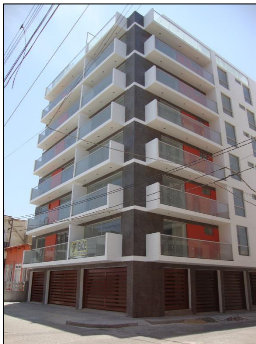
Fig. N° 3.7. Edificaciones de concreto armado, año de construcción mayor a 1997, con asesoría técnica, sistema estructural dual. (Esquina de calles José Quiñones y Torres Paz)
