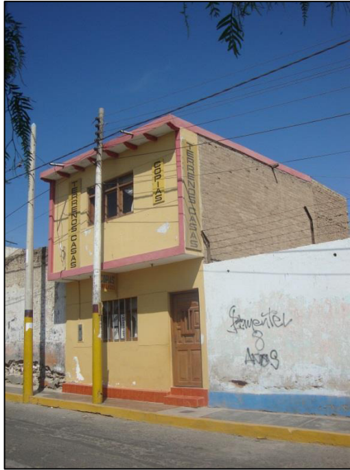
Fig. N° 3.6. Edificación de albañilería sin presencia de columnas de confinamiento. (Calle Leoncio Prado Cdra. 1)
