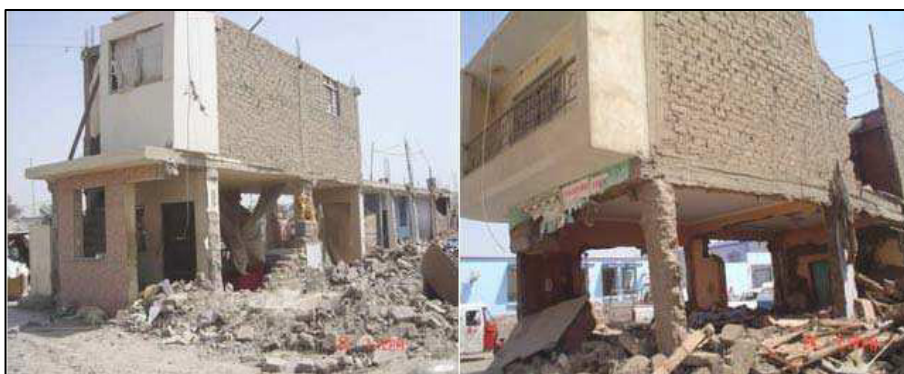
Fig. N° 1.27. Primer piso de adobe, segundo piso de albañilería. Pisco, Perú. (San Bartolomé A. 2007)
