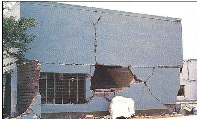
Fig. N° 1.17. Viviendas sin columnas y baja densidad de muros en la dirección paralela a la fachada. (Kuroiwa J. 2008)
