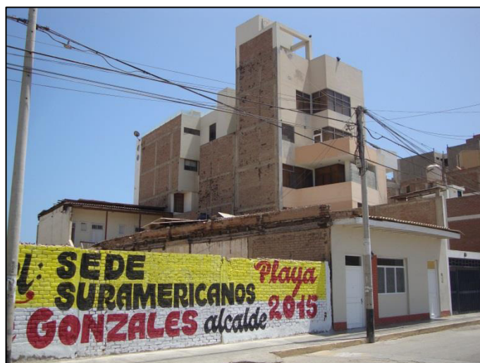
Fig. N° 3.17. Edificación de concreto armado con reducción de áreas techadas en los últimos niveles. (Calle Manuel Seoane Cdra. 5)
