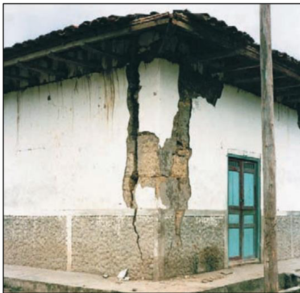
Fig. N° 1.13. Falla por flexión y corte cerca de las esquinas del muro, causadas por fuerzas de inercia que actúan perpendicularmente a la cara de las paredes. (Kuroiwa J. 2008)
