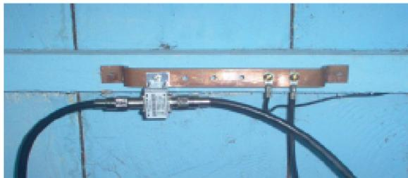
Figura N° 2.33: Protector de Línea Instalado en Barra Máster
