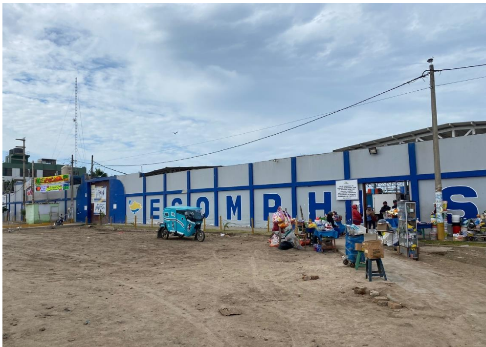
Imagen N°1: Fotografía Fachada principal de ECOMPHISA
