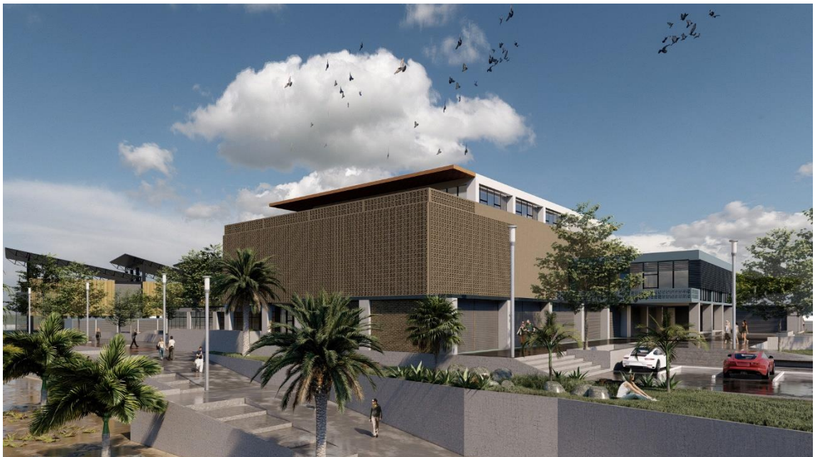
Imagen N°35: Vista Fachada Sur
