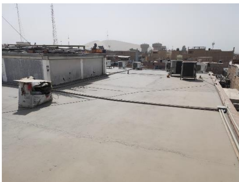
Figura 2: Techo aligerado del local
