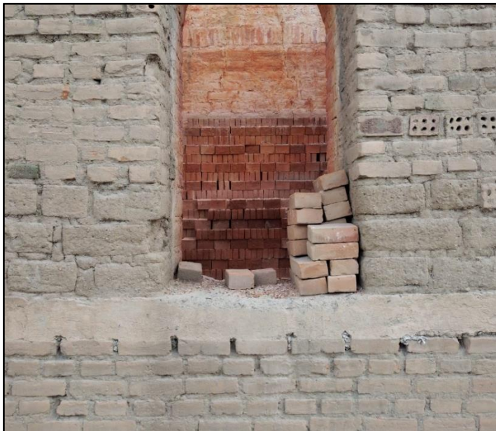
Figura 69: Enfriamiento de material
