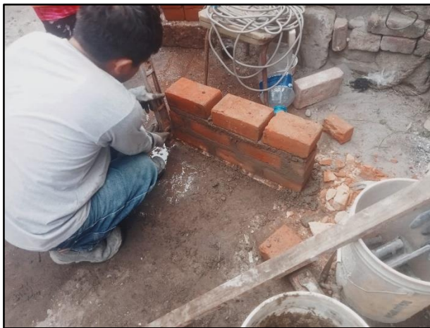
Figura 92: Colocado de mortero en muretes
