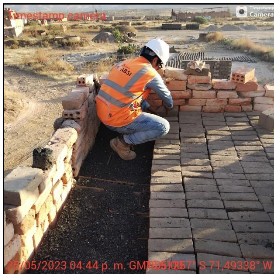
Figura 64: Apilado de ladrillo en horno
