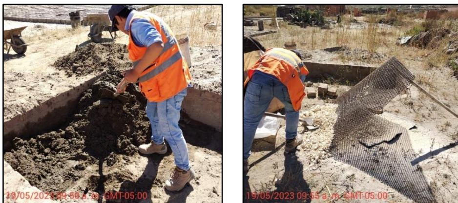
Figura 59: Dosificación de materiales
