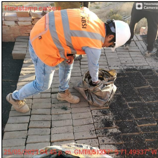
Figura 65: Colocado de carbón entre capas de ladrillo
