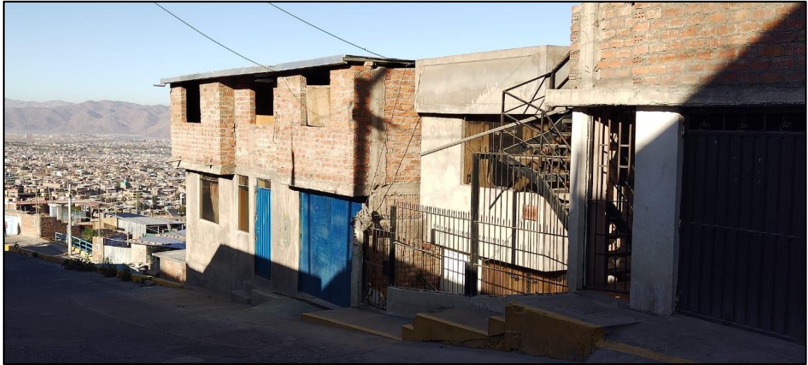
Figura 13: Viviendas con ladrillo artesanal precario
