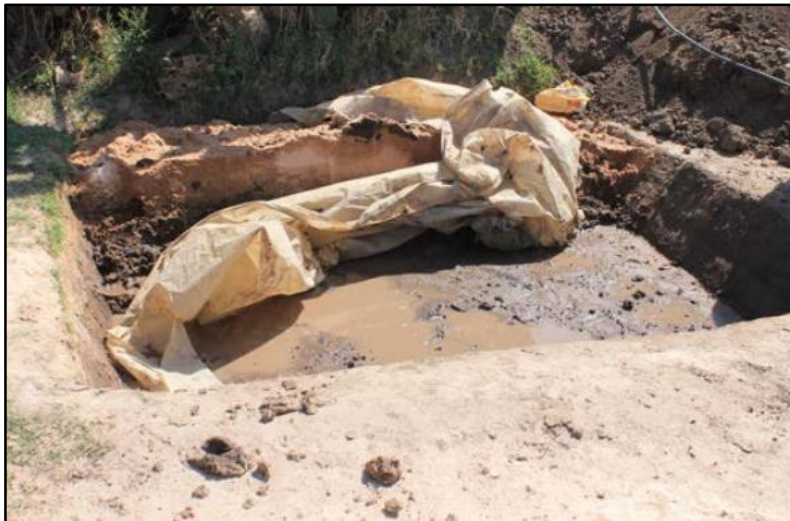
Figura 30: Pozos utilizados para el mezclado de materiales
