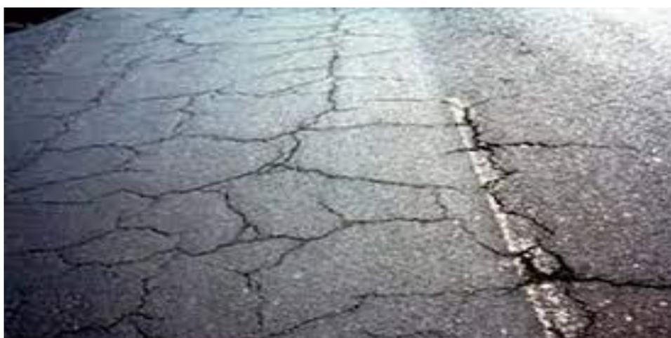
**Figura 31.** Agrietamiento en bloque
