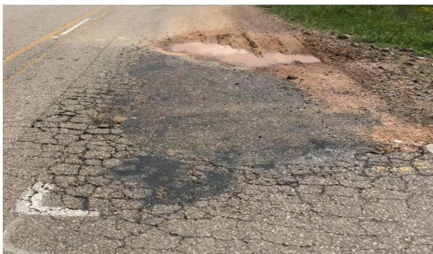
**Figura 47.** Desprendimiento de Agregados
