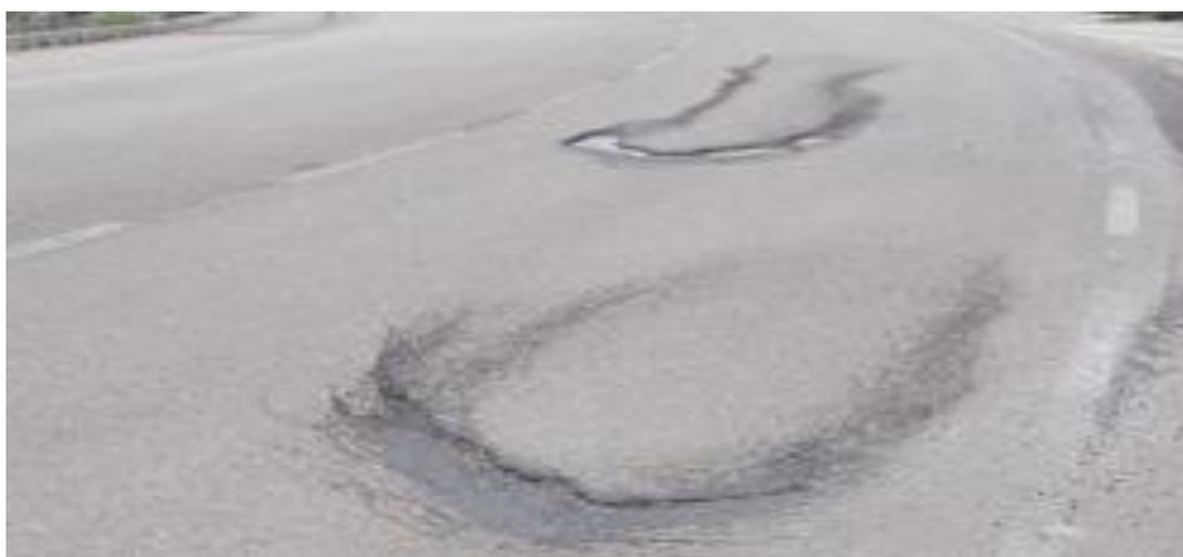
**Figura 45.** Grieta Parabólica
