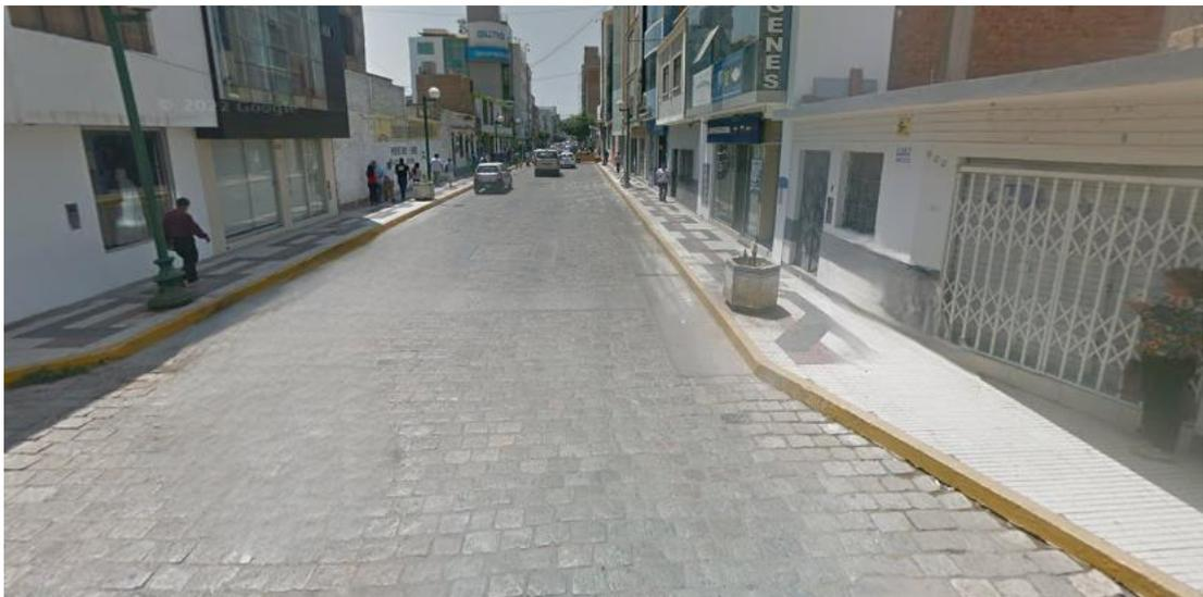
**Figura 20.** Pavimento adoquinado en la calle Manuel María Izaga
