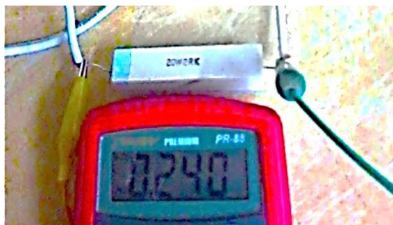
Figura 143 Medición del voltaje en la resistencia de dos ohmios de la máquina refileadora en reposo
