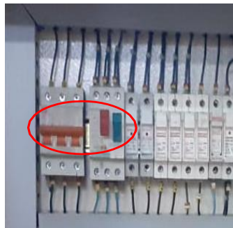
4 Subir los interruptores del tablero interno
