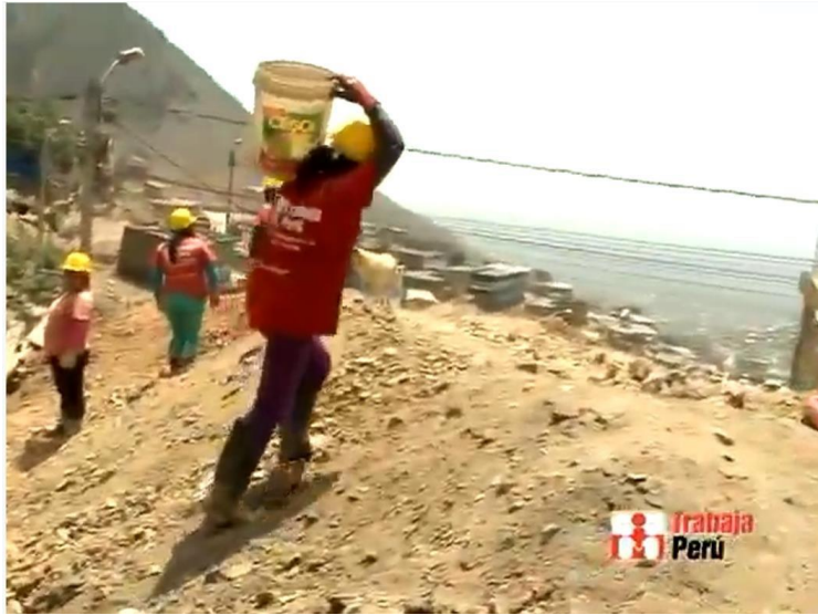
Martina Barrientos en plena jornada laboral en obra de construcción
