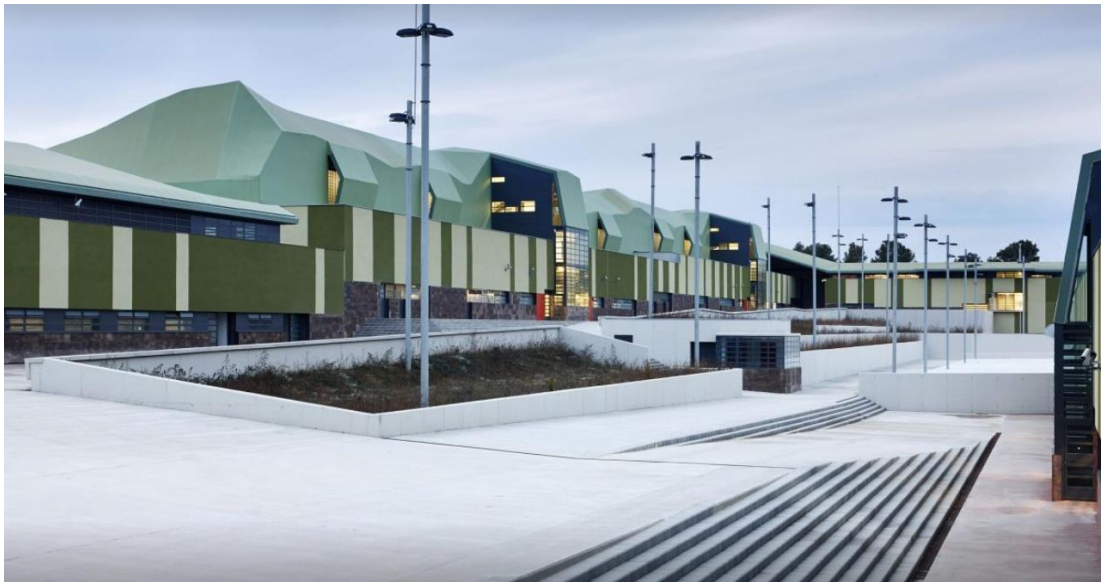
Figura N° 8. Zona interna de pabellones.
