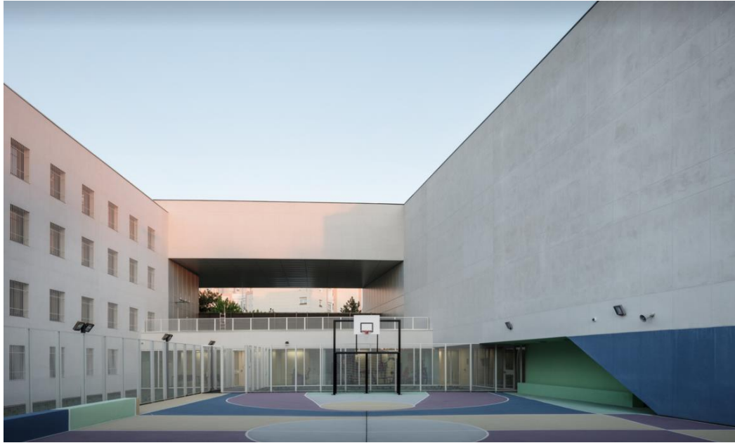
Figura N° 17. Patio zona interna.
