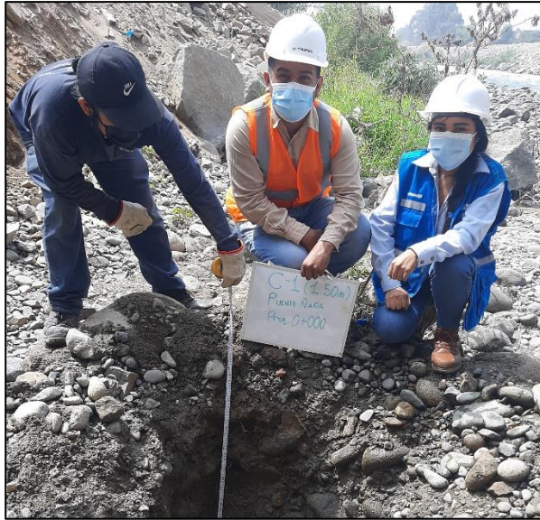
Figura 63: Calicata 1 – Puente Ñaña
