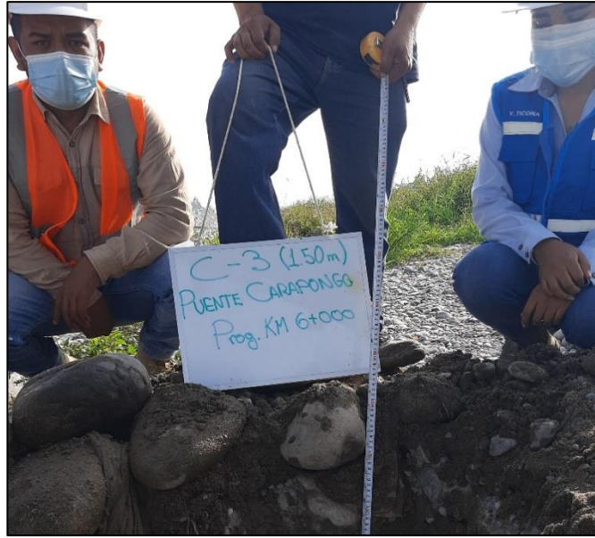
Figura 67: Calicata 3 – Puente Carapongo
