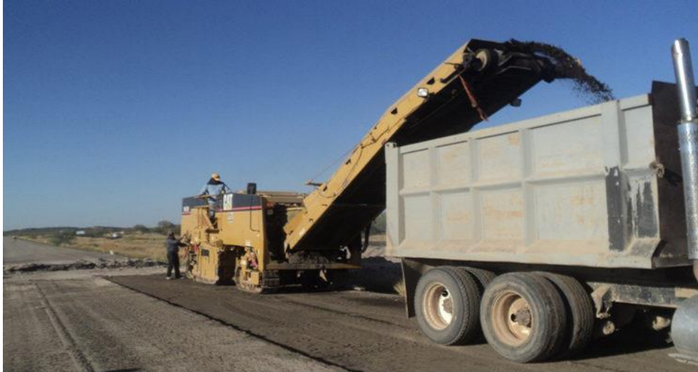
Figura 14. Rehabilitación de pavimento
