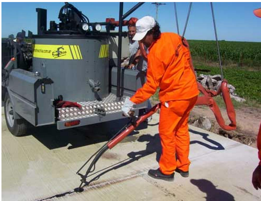
Figura 12. Sellado de pavimentos
