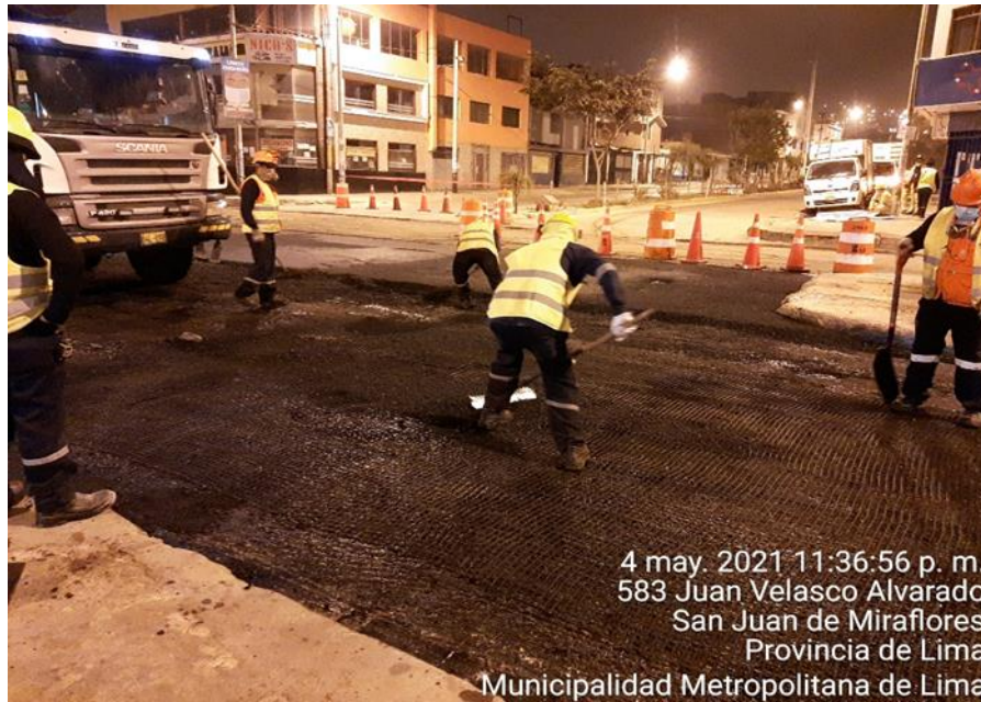
Figura 28. Colocación de geomalla biaxial de poliéster
