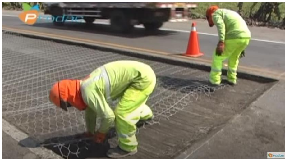
Figura 27. Colocación de malla de acero
