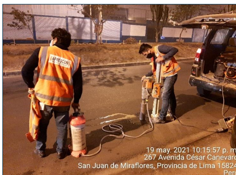
Figura 51. Extracción de muestra N° 02 con geomalla
