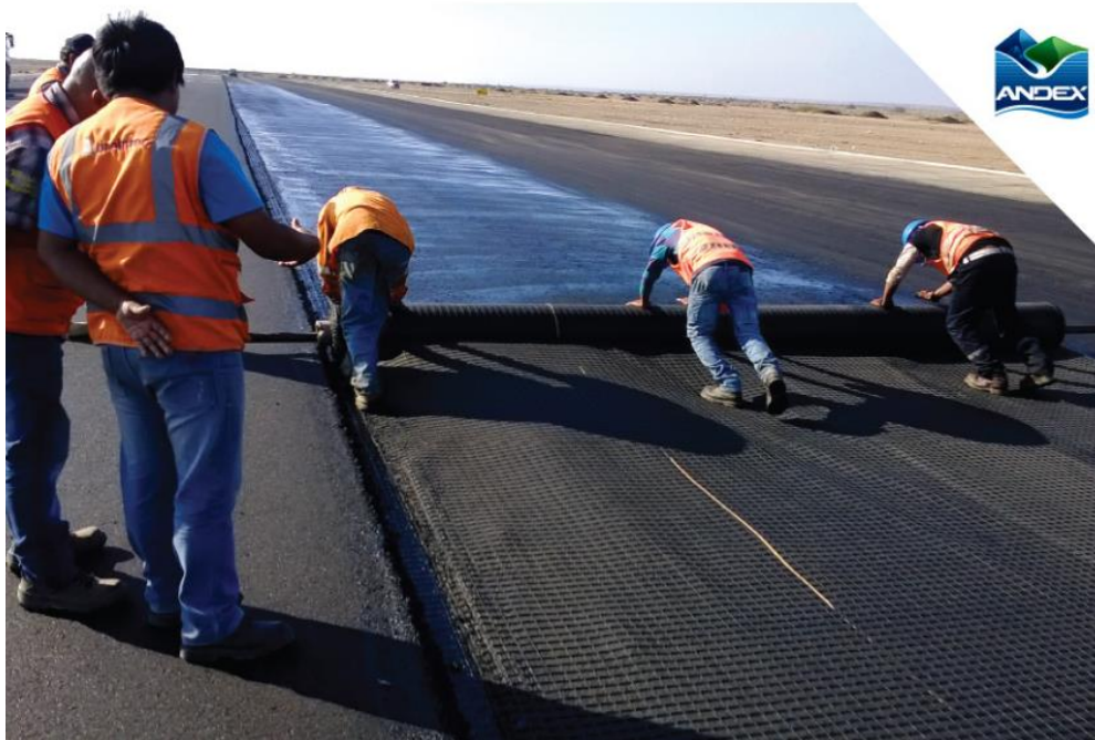
Figura 24. Colocación de mallas biaxiales de aramida
