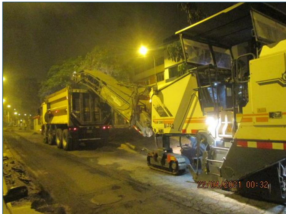
Figura 32. Fresado del pavimento
