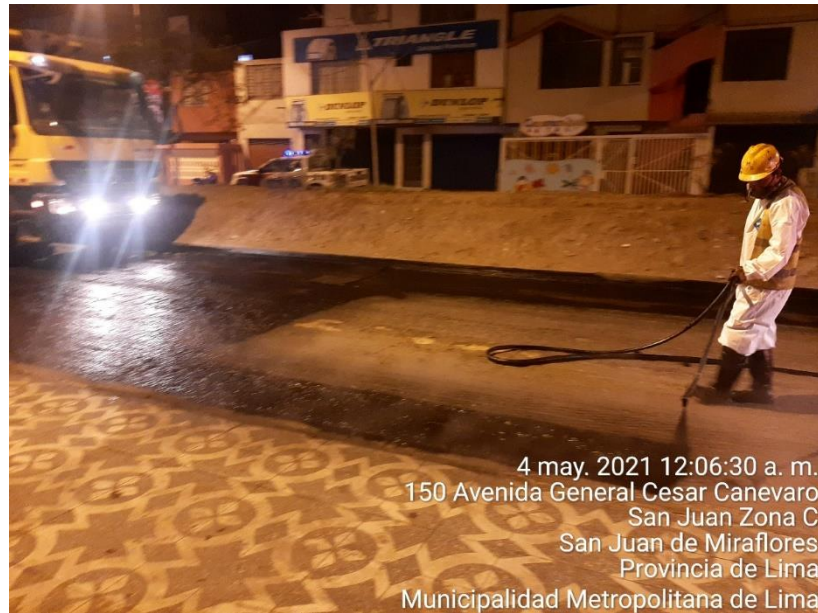
Figura 16. Aplicación de riego de liga
