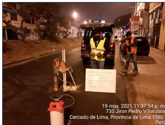
Figura 59. Extracción de muestra N° 06 sin geomalla Elaborado por: los autores
