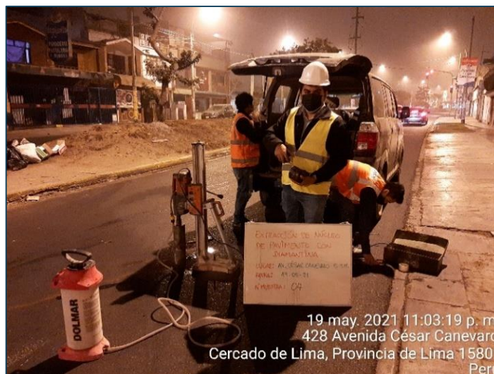
Figura 56. Extracción de muestra N° 04 con geomalla Elaborado por: los autores
