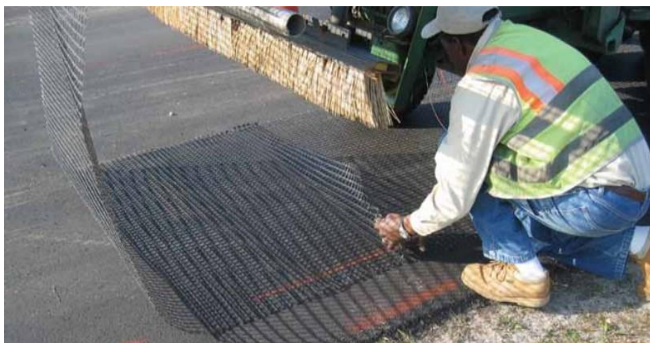
Figura 26. Colocación de geomallas biaxiales
