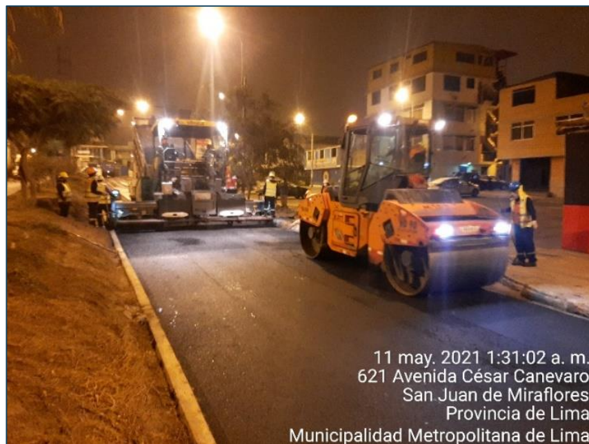
Figura 38. Compactación de carpeta asfáltica
