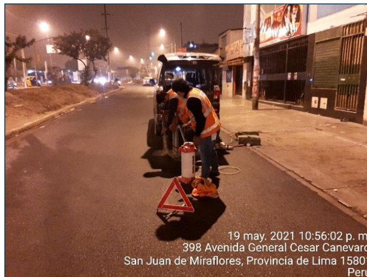
Figura 55. Extracción de muestra N° 04 con geomalla Elaborado por: los autores
