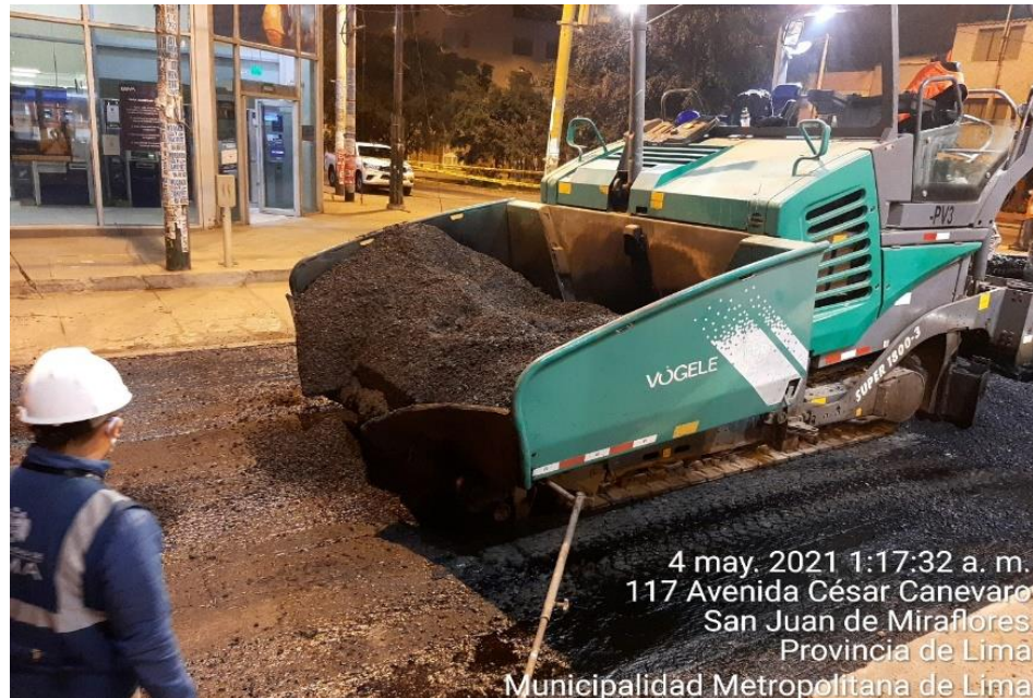
Figura 17. Mezcla de concreto asfáltico
