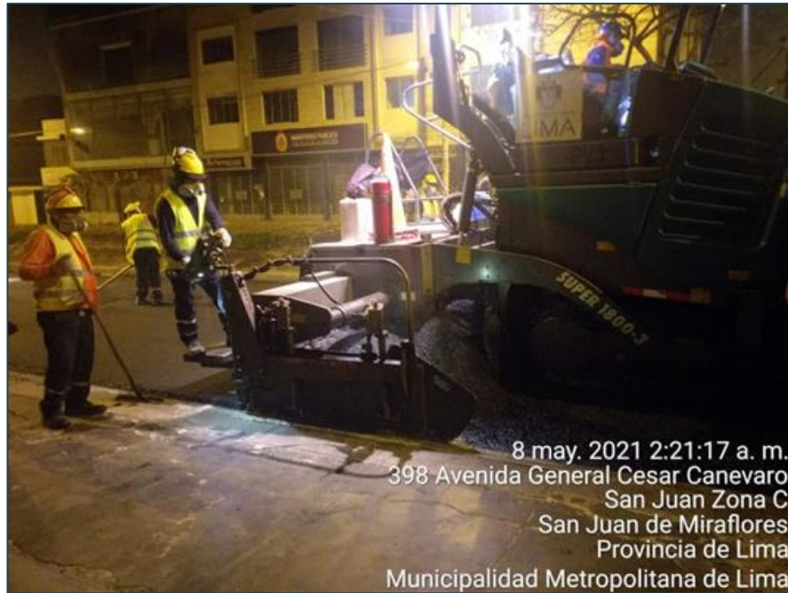
Figura 37. Colocación de carpeta asfáltica con pavimentadora
