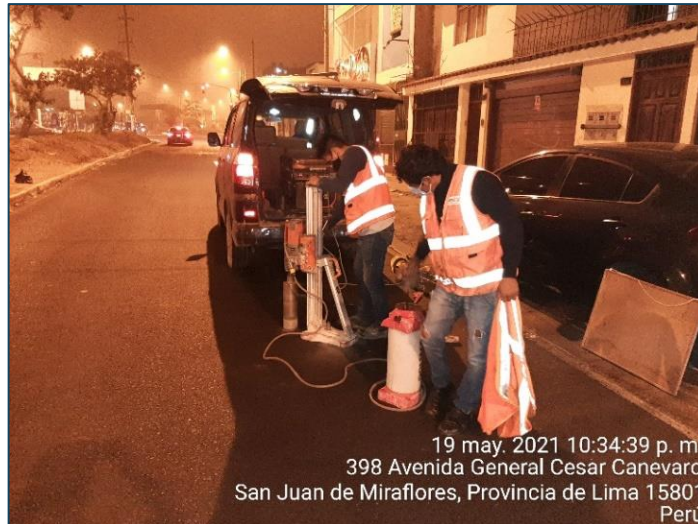
Figura 54. Extracción de muestra N° 03 con geomalla Elaborado por: los autores
