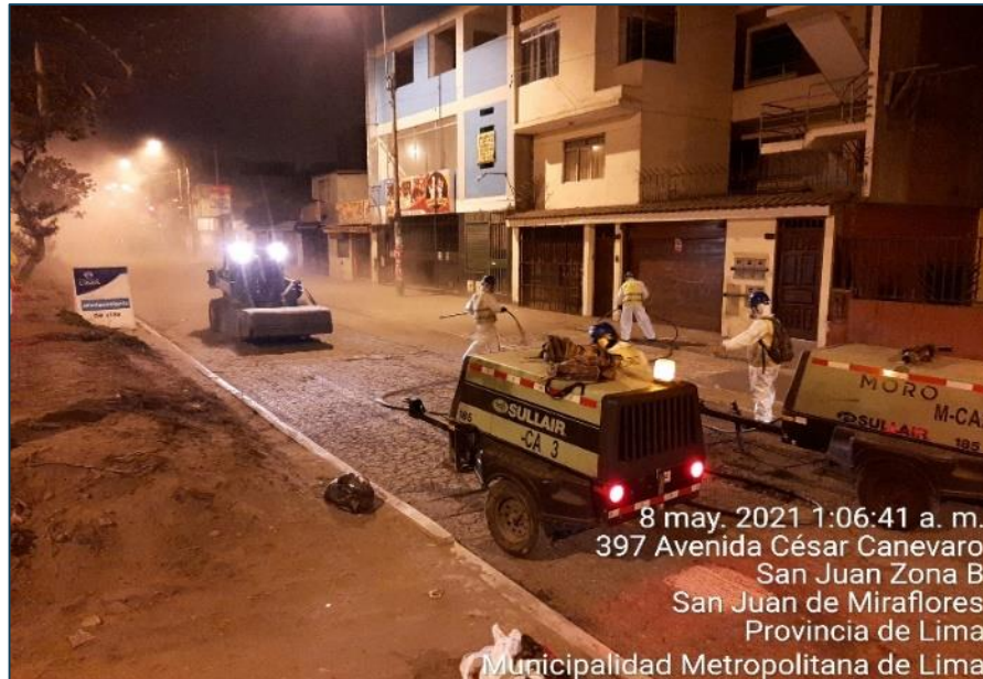
Figura 33. Limpieza de superficie con soplores mecánicos
