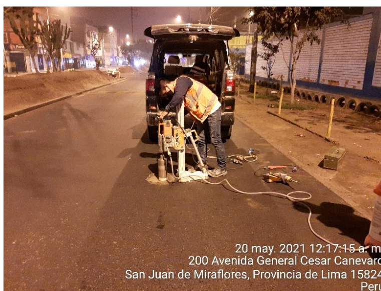
Figura 49. Extracción de muestra N° 01 sin geomalla Elaborado por: los autores
