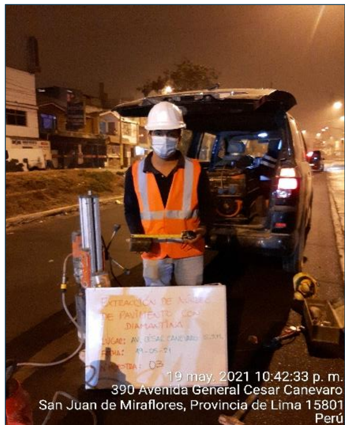
Figura 53. Extracción de muestra N° 03 con geomalla
