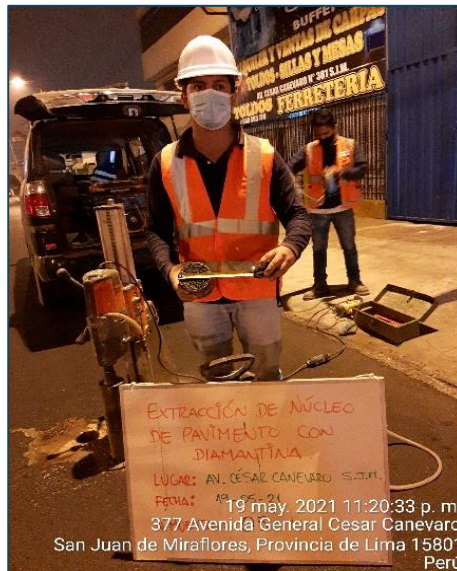
Figura 58. Extracción de muestra N° 05 sin geomalla Elaborado por: los autores
