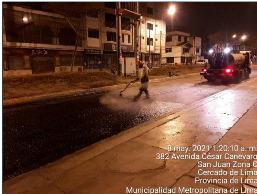
Figura 35. Aplicación de riego de liga
