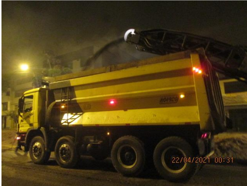
Figura 18. Descarga de material fresado hacia volquete
