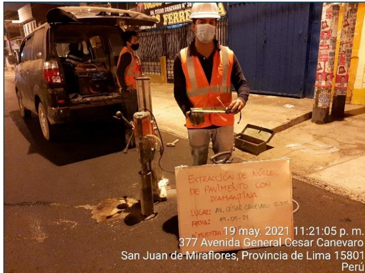
Figura 57. Extracción de muestra N° 05 sin geomalla Elaborado por: los autores
