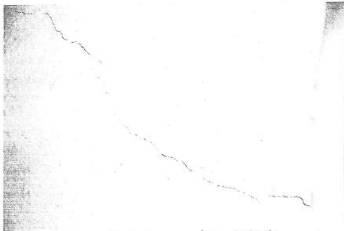
Rajadura de Techo de pasadizo 2do piso
