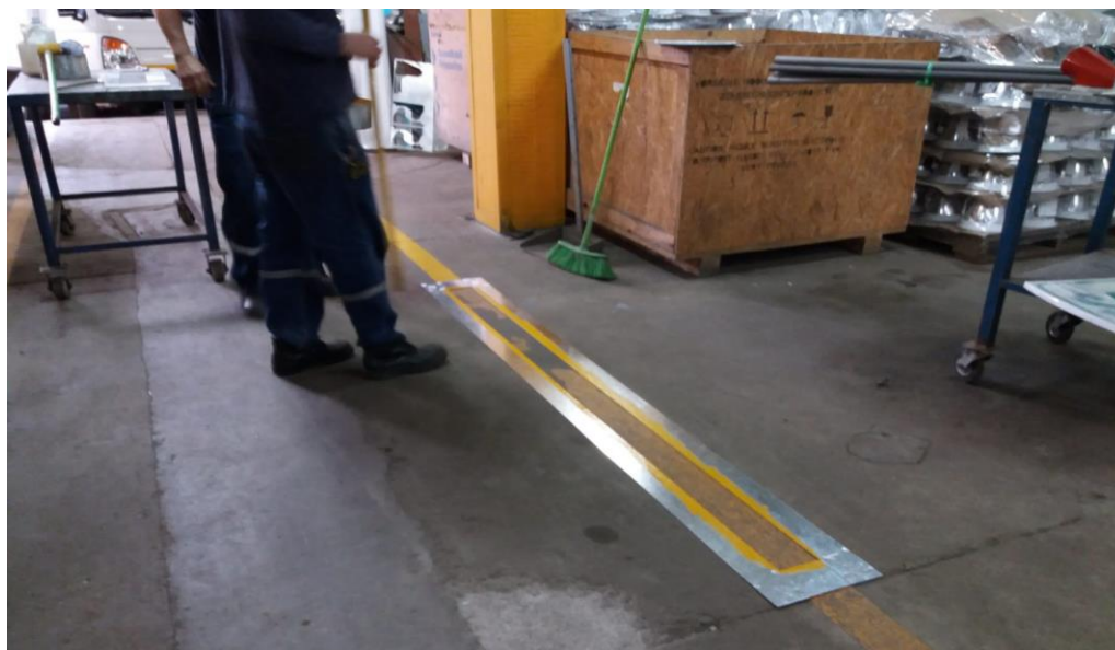
Figura 212. Pintado de franjas amarillas de señalización Adaptado por los autores de la información proporcionada por la empresa Industrias Jelco E.I.R.L
