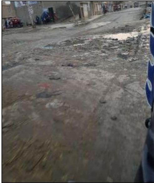
El la figura se aprecia que en el tramo km 0+100 aproximadamente que el pavimento rígido de la vía canal está severamente dañada por la pérdida de la subrasante ya que se encuentra baches de hasta 30cm de profundidad aproximadamente, lo cual nos dio a entender que el material (subrasante) se encontraba en un estado saturado y con el pasar de los vehículo pesados este hacia el efecto de sifonamiento dejando sin apoyo al pavimento rígido.
