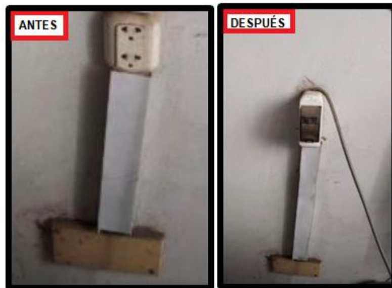
Figura YY 24. Cambio de tomacorriente común por llaves de paso Elaborado por: los autores
