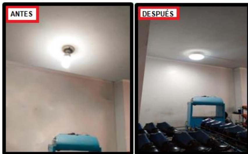
Figura YY 26. Cambio de focos convencionales por focos led Elaborado por: los autores
