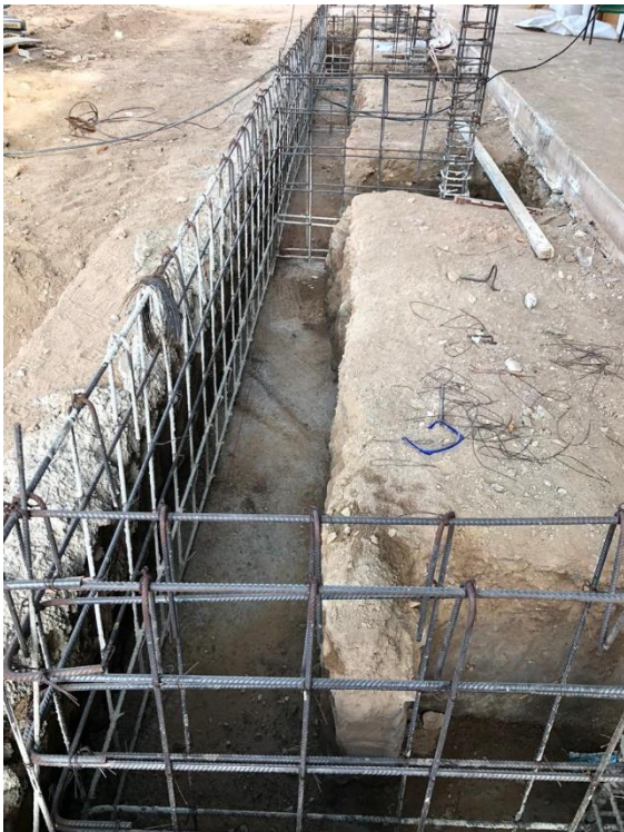
Fotografía 008: Colocación de aceros en Graderías y Desencofrado.
