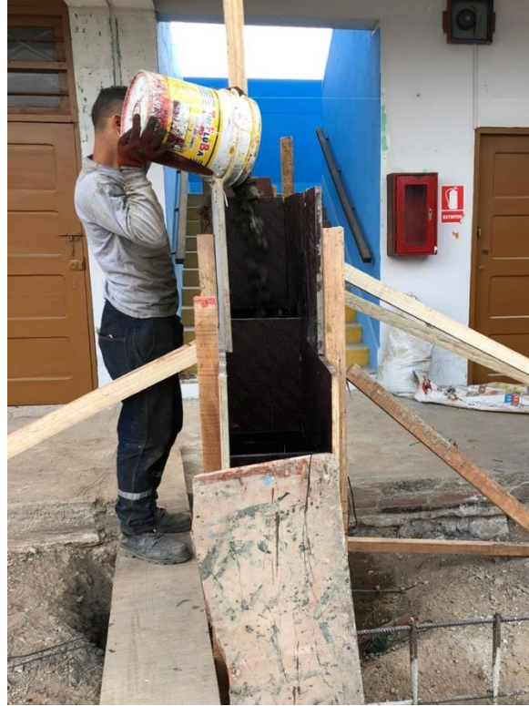
Fotografía 006: Vaciado de concreto en Columnas, Zapatas y Sardineles.
