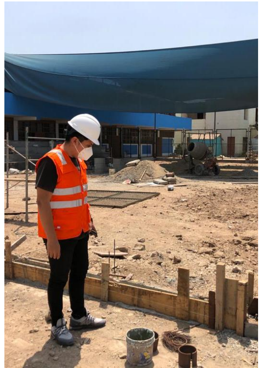
Fotografía 007: Retiro de Accesorios en columnas, zapatas y sardineles.
