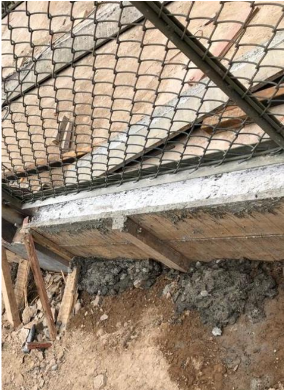
Fotografía 006: Vaciado de concreto en Columnas, Zapatas y Sardineles.
