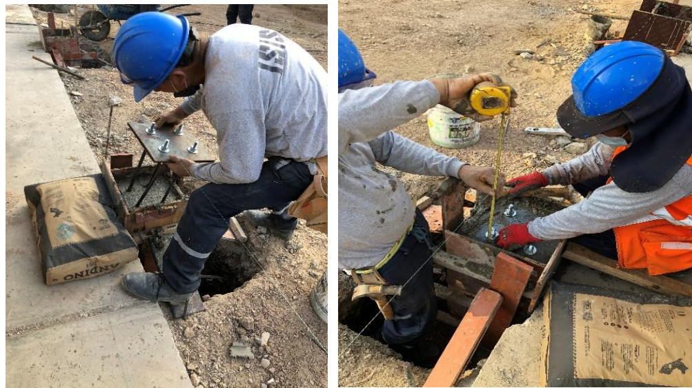
Figura 20: Acero de refuerzo - columnas
