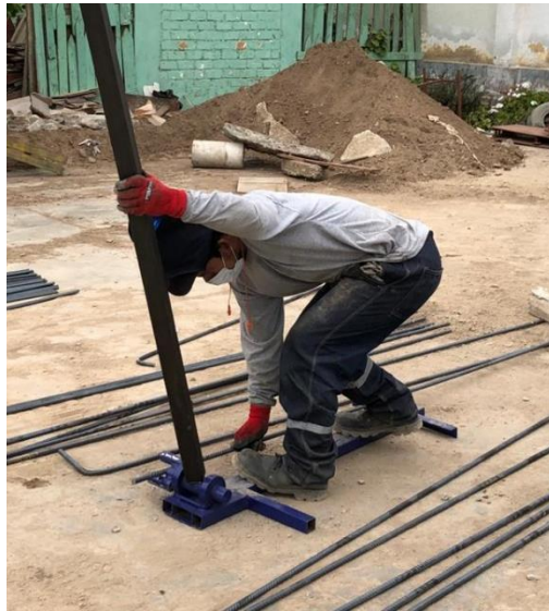
Fotografía 003: Doblaje de los Estribos para las columnas y Zapatas.
