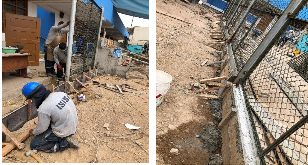
Figura 26: Sardinel peraltado con concreto
