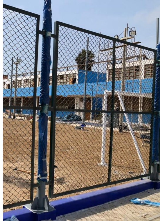
Fotografía 009: Colocación y acabado de postes metálicos y mallas metálicas.
