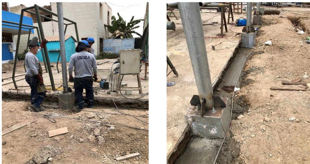
Figura 24: Estructura metálica y cobertura
