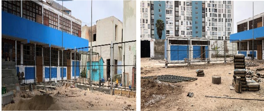
Figura 27: Carpintería metálica y herrería
