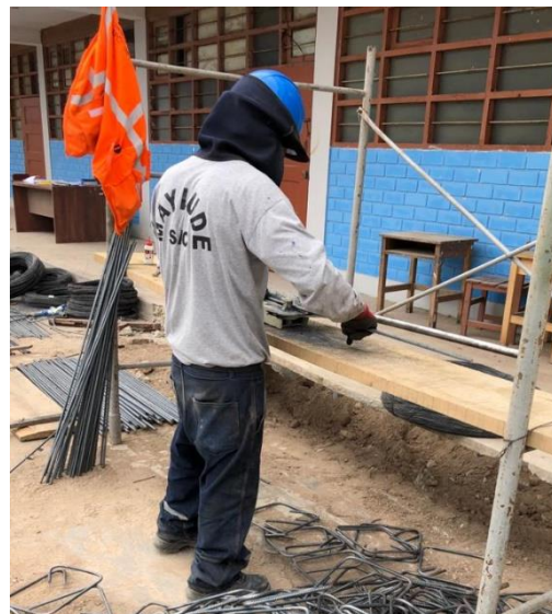
Fotografía 003: Doblaje de los Estribos para las columnas y Zapatas.
