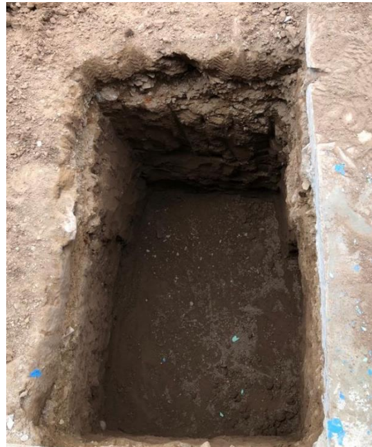
Fotografía 002: Excavación para el solado, zapatas y columnas h=1.20\text{m} .
