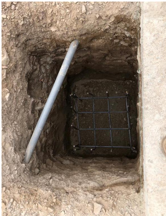
Fotografía 004: Colocación de acero en Zapatas y Columnas.
