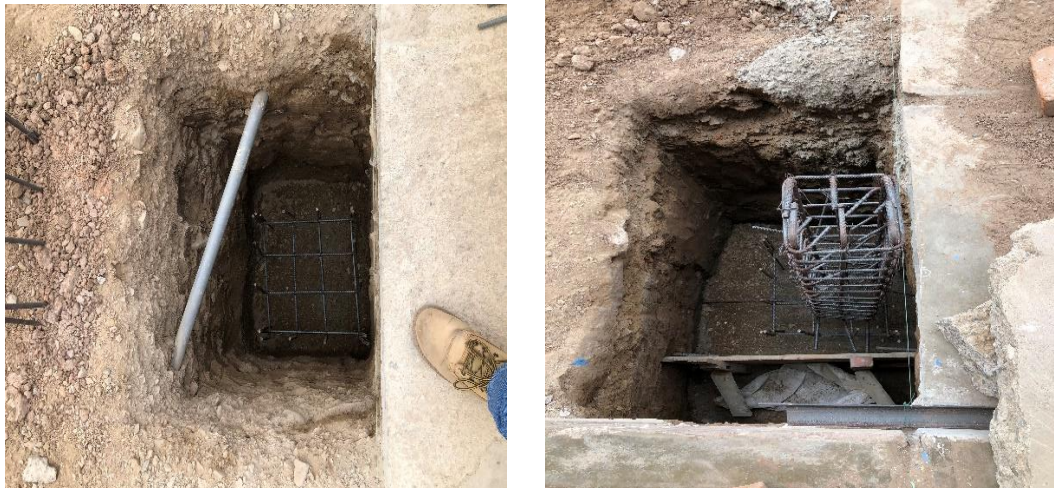
Figura 18: Acero de refuerzo - zapatas
