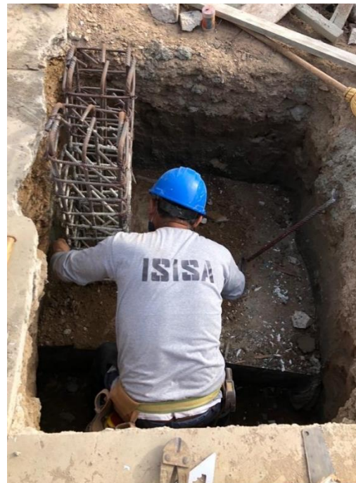
Fotografía 004: Colocación de acero en Zapatas y Columnas.
