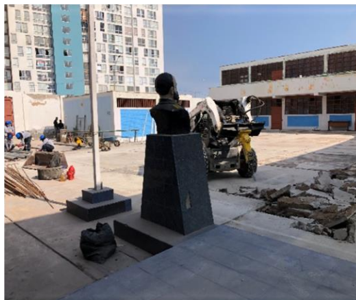
Figura 14: Procedimiento constructivo demolición de losa de concreto
