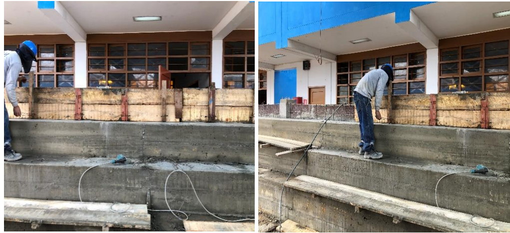
Figura 23: Gradería encofrado y desencofrado
