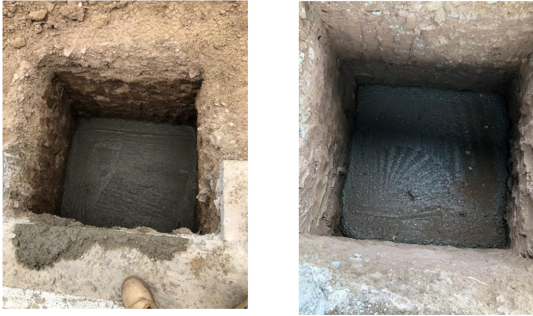
Figura 16: Concreto simple y solado de concreto
