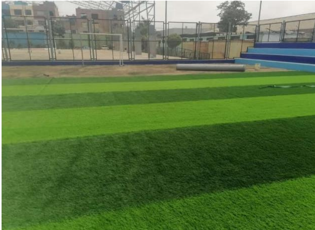
Fotografía 011: Colocación de la alfombra de Grass Sintético.
