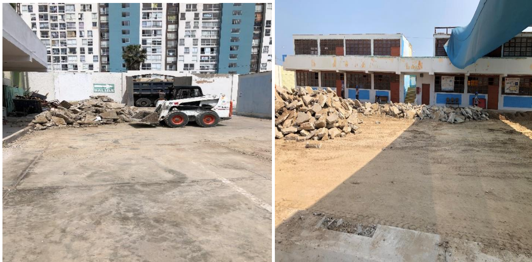
Figura 15: Eliminación de material de demolición
