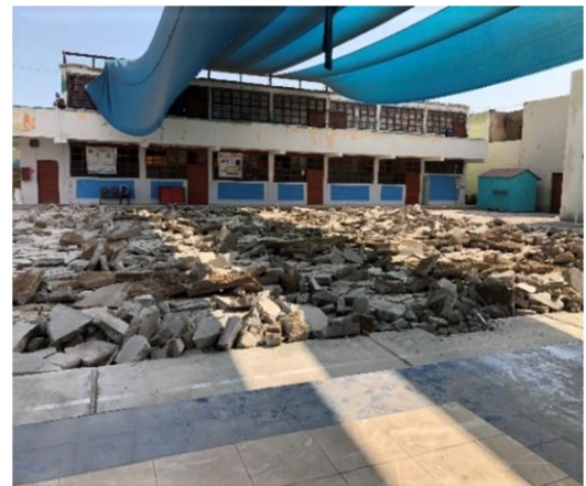
Figura 14: Procedimiento constructivo demolición de losa de concreto
