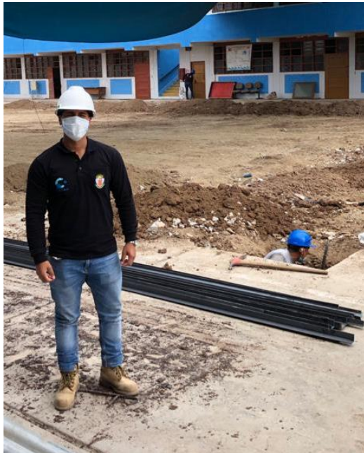
Fotografía 002: Excavación para el solado, zapatas y columnas h=1.20\text{m} .
