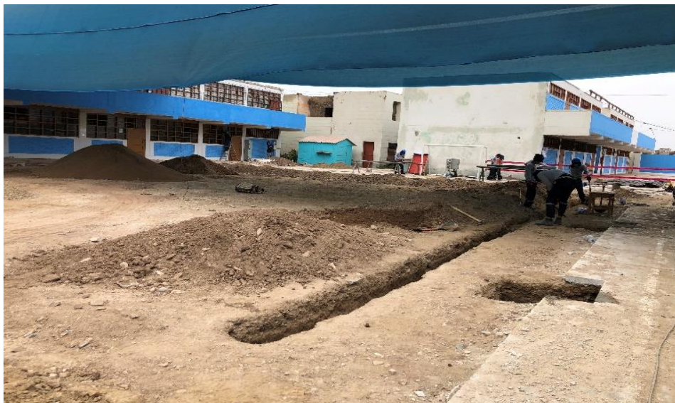
Figura 25: Excavación manual para cimiento en cerco perimétrico
