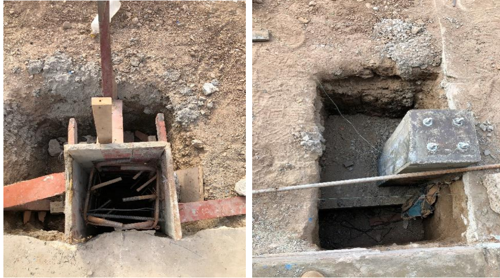
Figura 19: Columnas de concreto, encofrado y desencofrado
