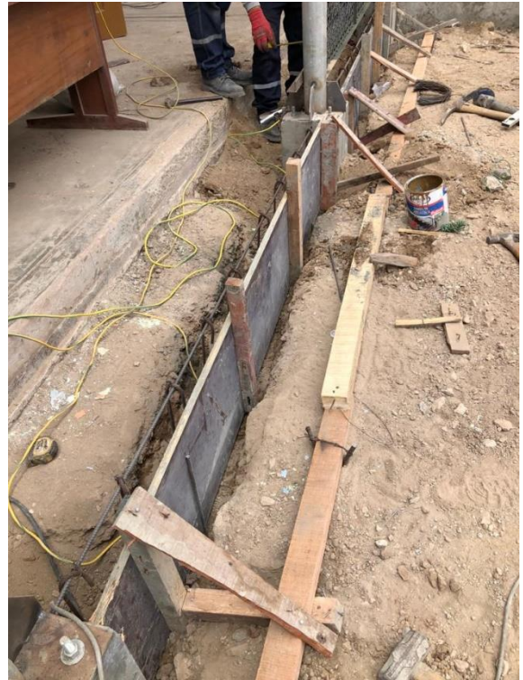
Fotografía 005: Colocación de accesorios en Columnas y Sardineles.
