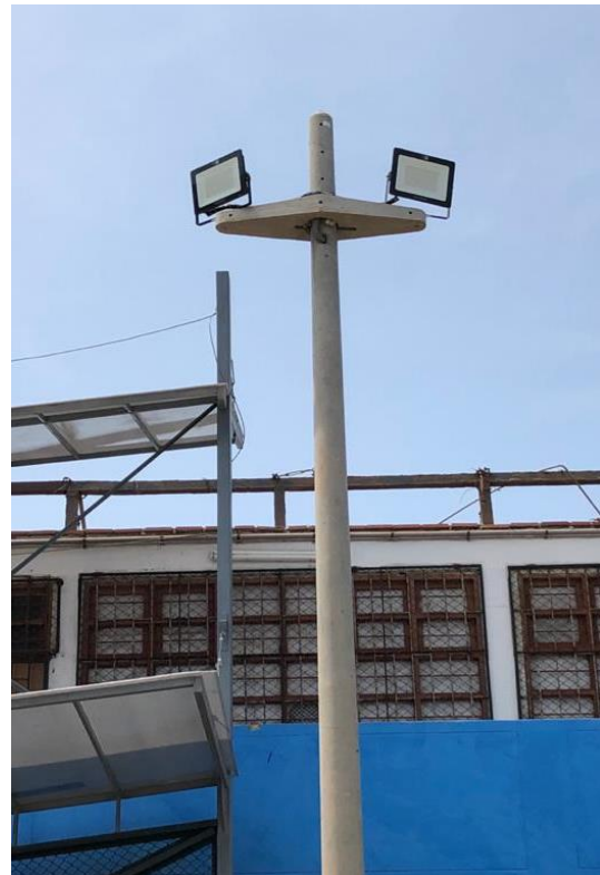
Fotografía 010: Colocación de Luces led de 250w y acabado de graderías
