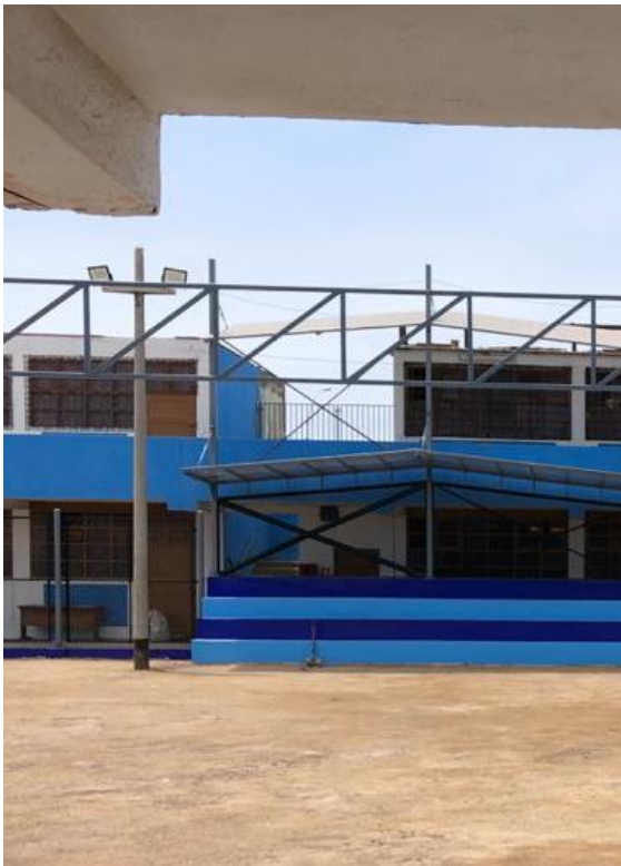
Fotografía 010: Colocación de Luces led de 250w y acabado de graderías
