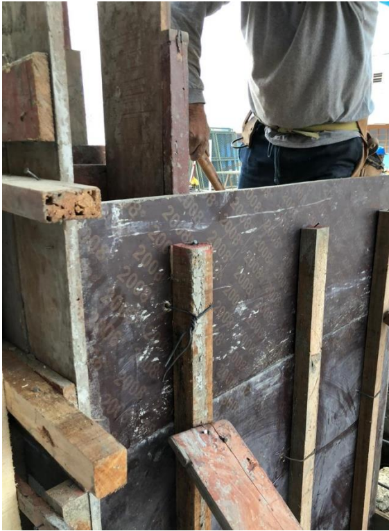
Fotografía 007: Retiro de Accesorios en columnas, zapatas y sardineles.
