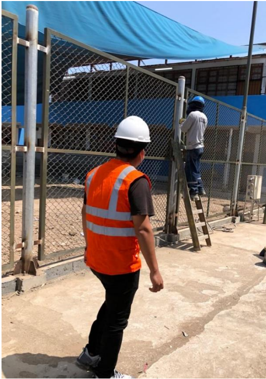
Fotografía 009: Colocación y acabado de postes metálicos y mallas metálicas.
