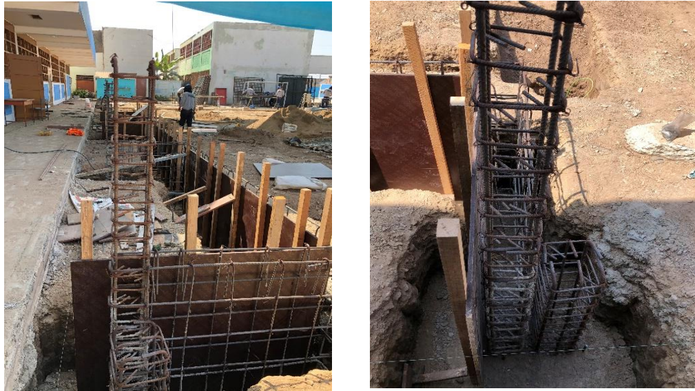
Figura 21: Muro de gradería, acero de refuerzo
