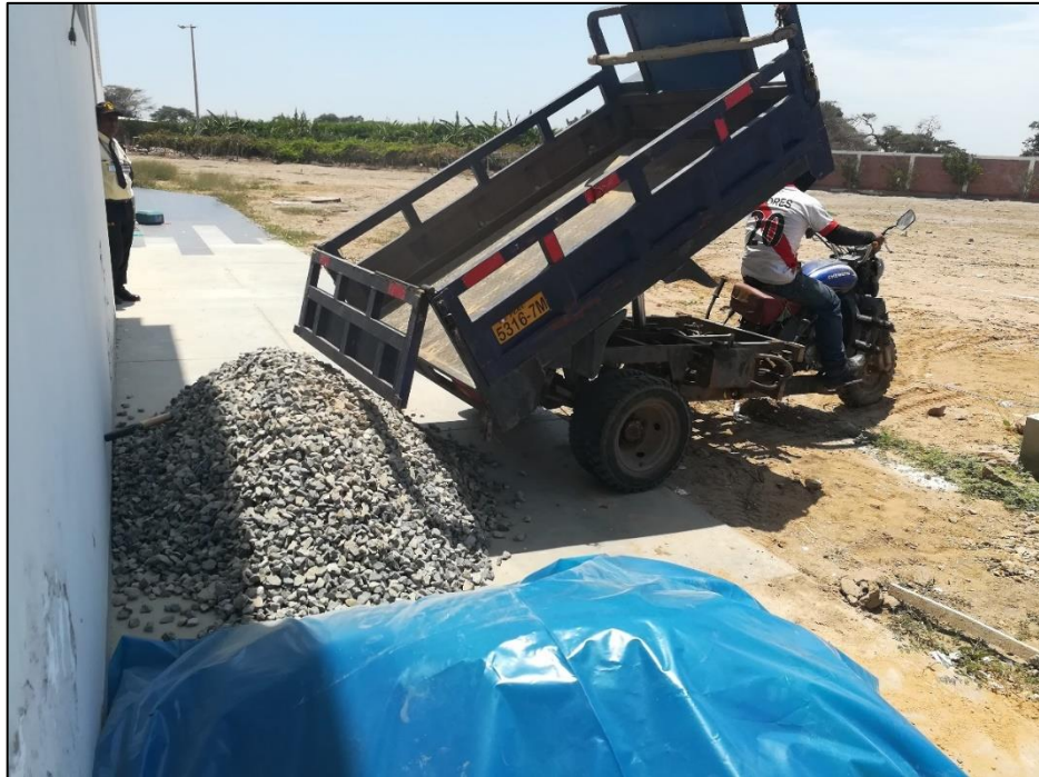
Fotografía 1. Acopio de agregado grueso en frontis de laboratorio
