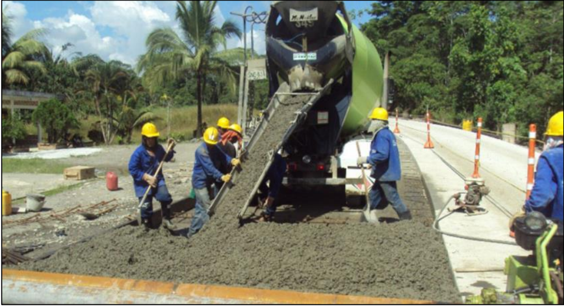
Figura 6. Transporte del concreto
