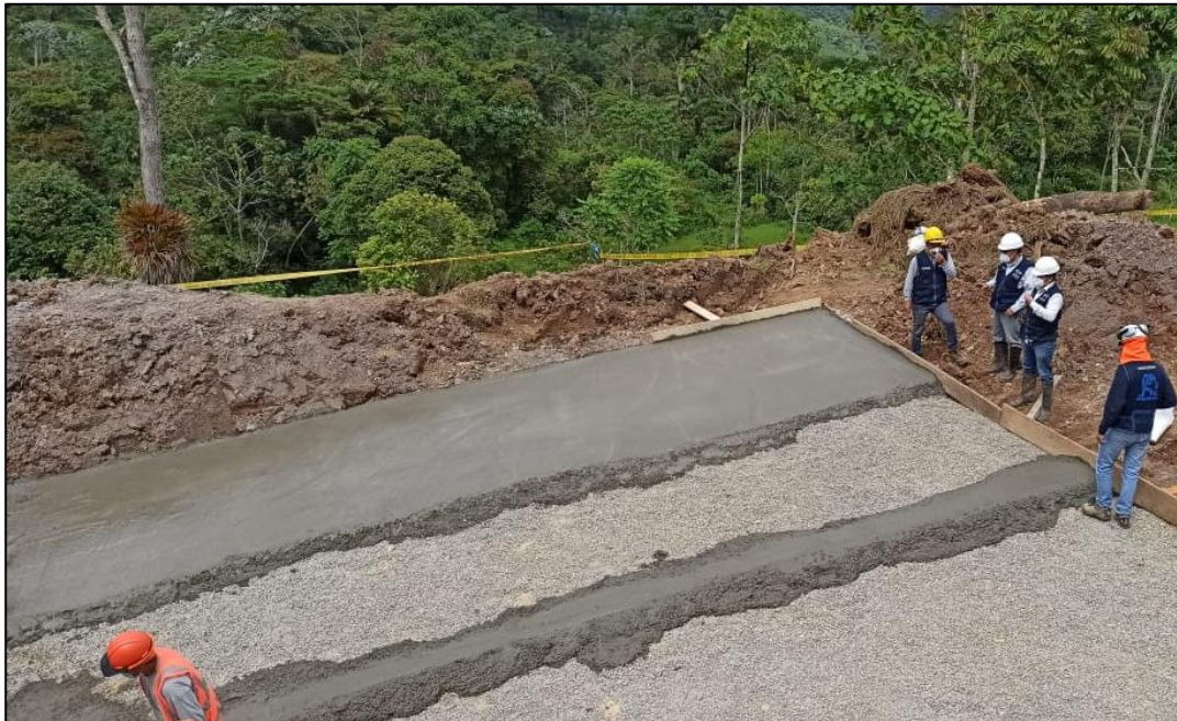
Figura 5. Fabricación y puesta en obra del concreto
