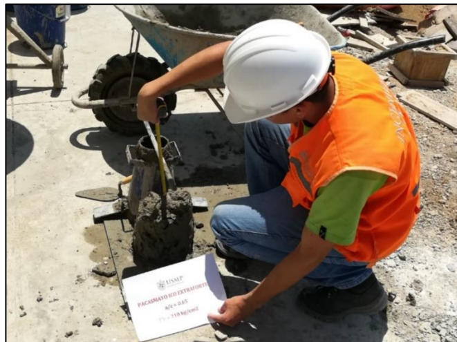
Figura 44. Proceso para la trabajabilidad del concreto fresco
