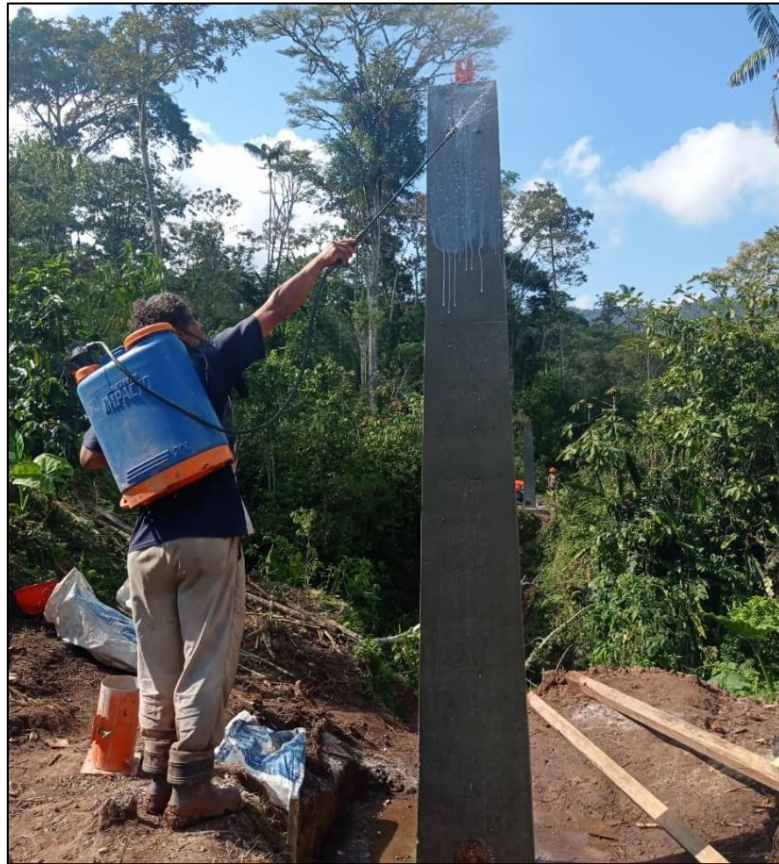
Figura 8. Curado con aditivo
