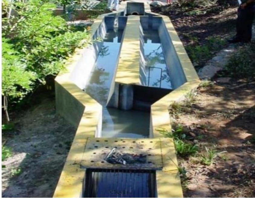
**Figura 12.** Desarenador en paralelo
