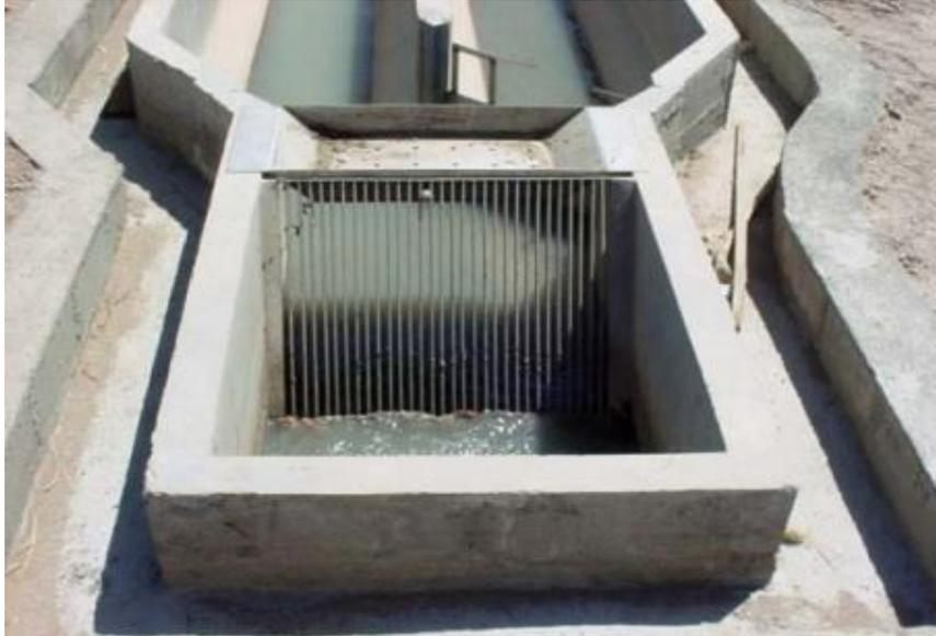
**Figura 11.** Cámara de rejillas en operaciones
