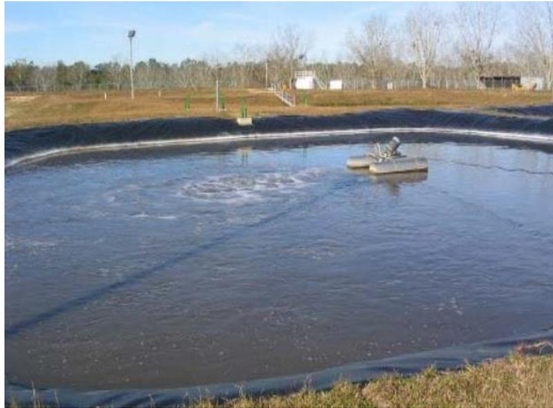
**Figura 18.** Laguna de oxidación aerobia
