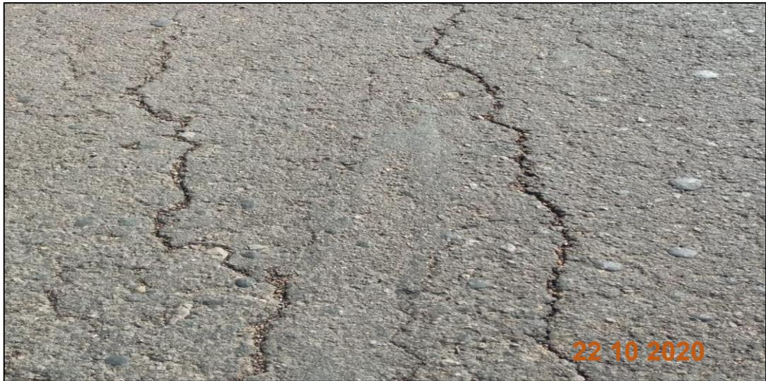
Figura N°21: Grietas longitudinales de leve severidad, carretera Pimentel (2020).
