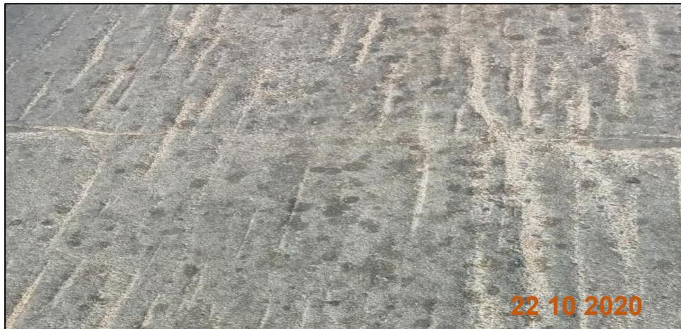
Figura N°28: Grietas parabólicas, de media severidad, carretera Pimentel (2020).
