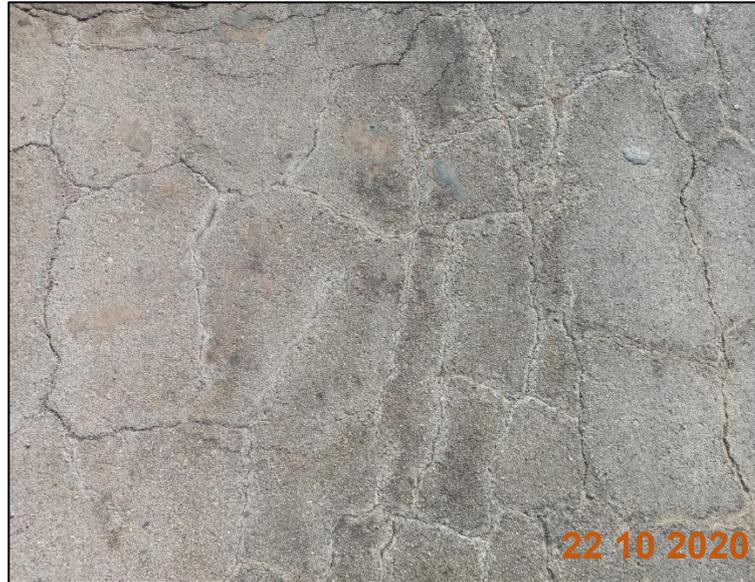
Figura N°14: Agrietamiento en bloque, leve severidad, carretera Pimentel (2020)
