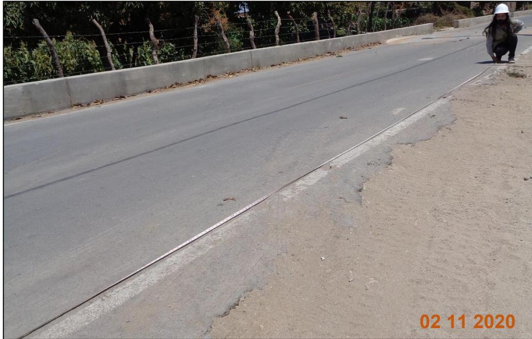
Figura N°18: Grieta de Borde de media severidad, carretera Pimentel (2020).
