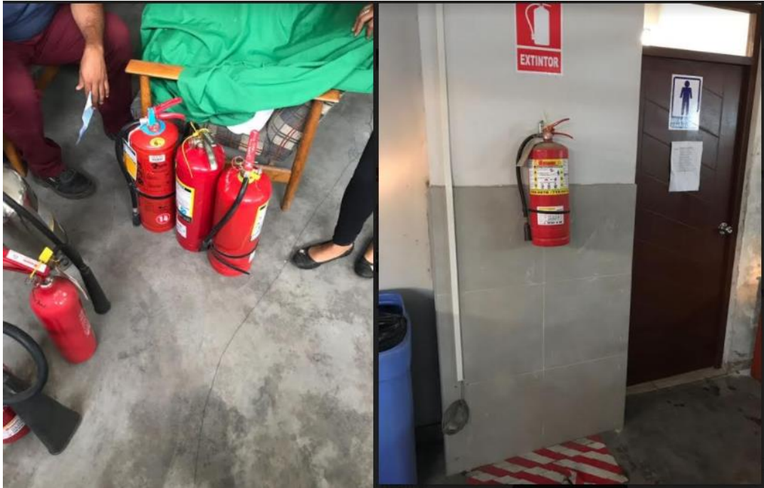
Figura AJ14. Señalización extintores Elaboración: Los autores
