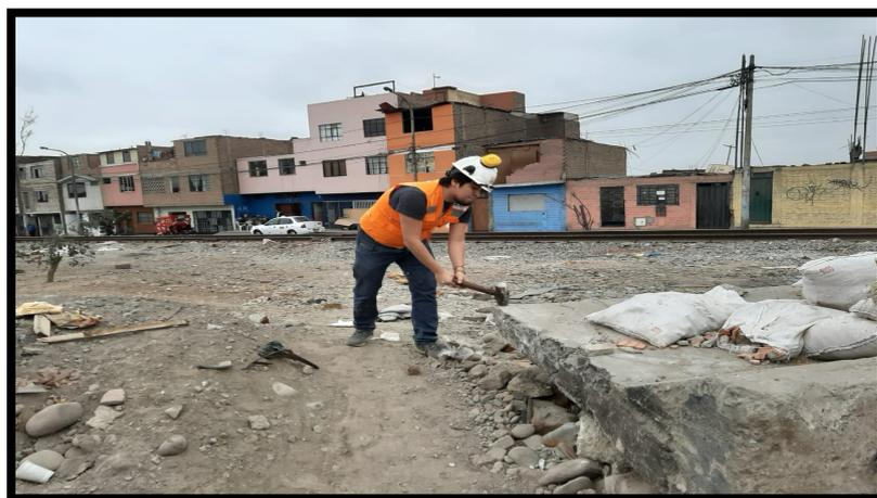
**Figura 23:** Fragmentación del concreto reciclado
