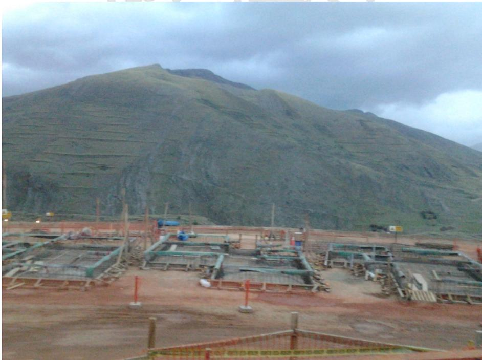
Foto 10: Encofrado de platea de cimentación
