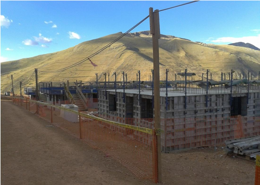
Foto 11: Encofrado de muro de 1er nivel.
