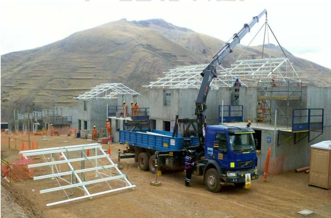
Foto 16: Colocación de la estructura metálica.
