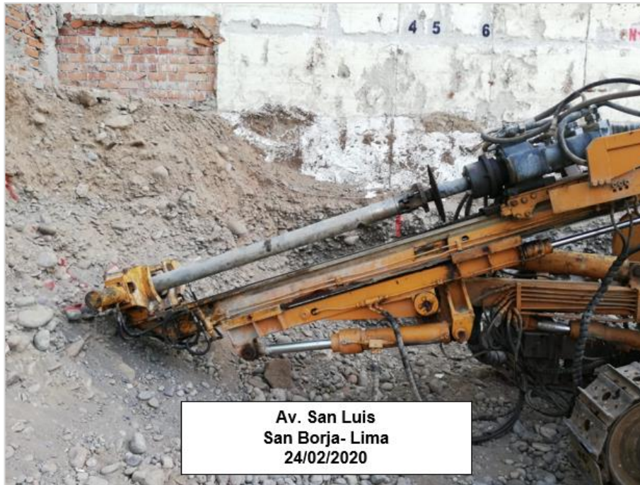
Figura 17. Ejecución de anclaje Fuente: Elaboración propia
