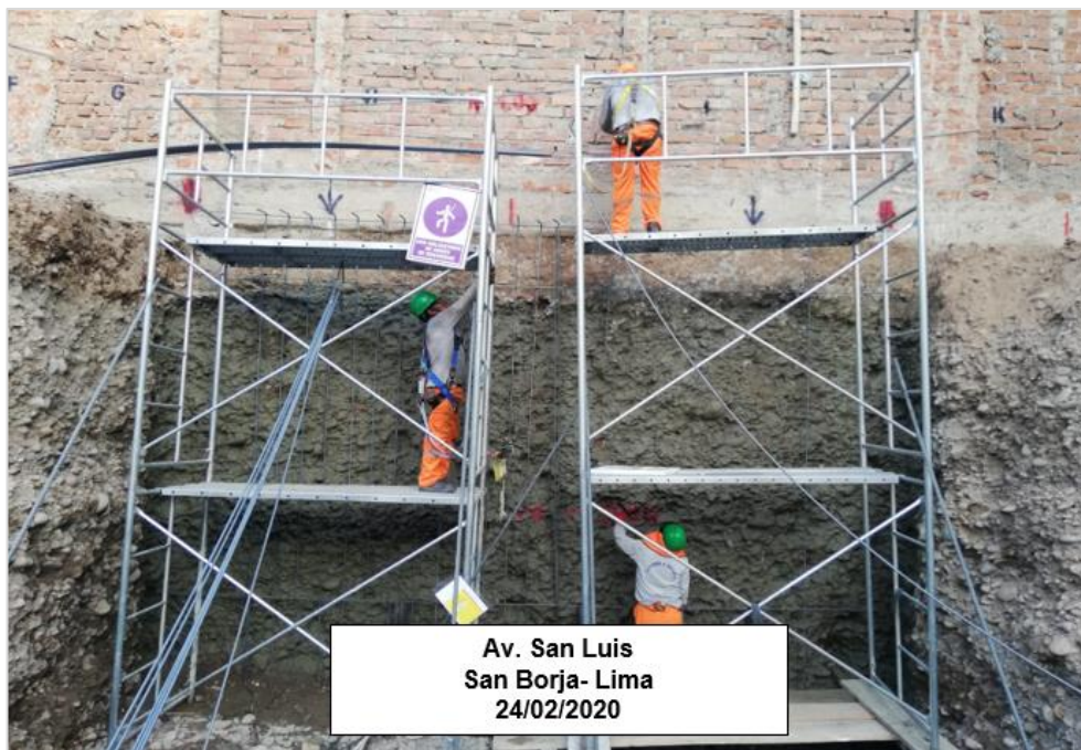
Figura 18. Colocación de armadura, encofrado y concreto Fuente: Elaboración propia
