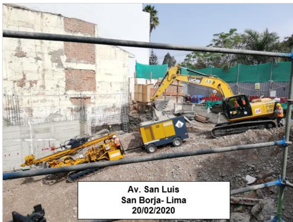
Figura 12. Muros anclados Fuente: Elaboración propia
