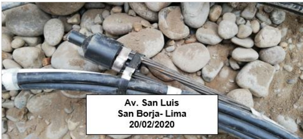
Figura 14. Cabeza de anclaje Fuente: Elaboración propia
