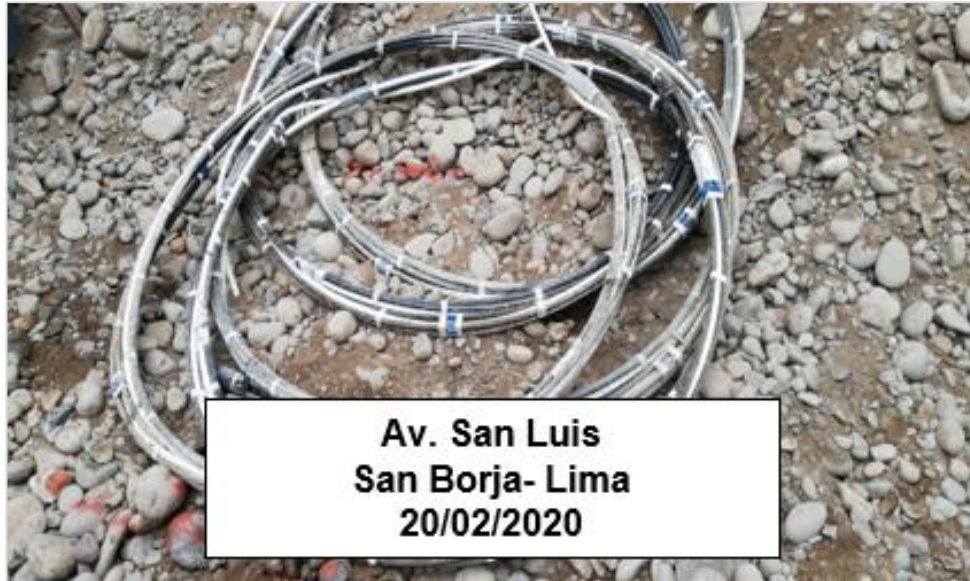
Figura 13. Anclajes de muro Fuente: Elaboración propia
