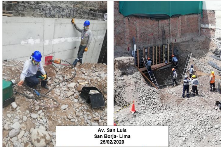
Figura 19. Desencofrado y tensado Fuente: Elaboración propia
