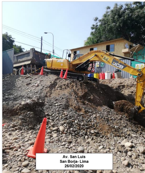
Figura 20. Excavación al siguiente nivel Fuente: Elaboración propia
