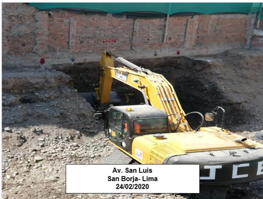
Figura 16. Excavación Fuente: Elaboración propia
