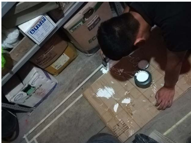
Figura 224. Pintado de líneas de demarcación Fuente: Elaboración de los autores.
