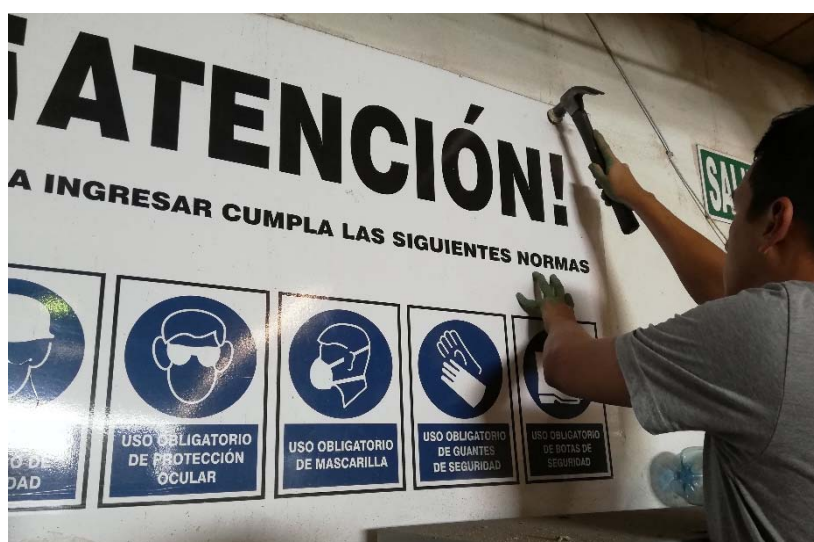
Figura 338. Evidencia fotográfica 2 de señalización de áreas Fuente: Elaboración de los autores.
