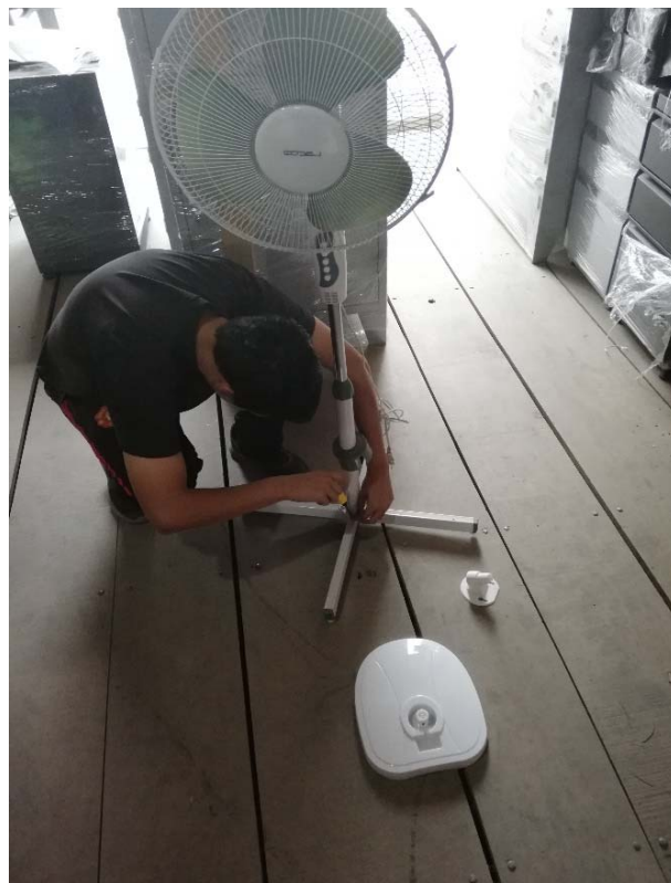
Figura 286. Instalación de ventilador Fuente: Elaboración de los autores.
