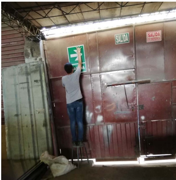
Figura 339. Evidencia fotográfica 3 de señalización de áreas Fuente: Elaboración de los autores.
