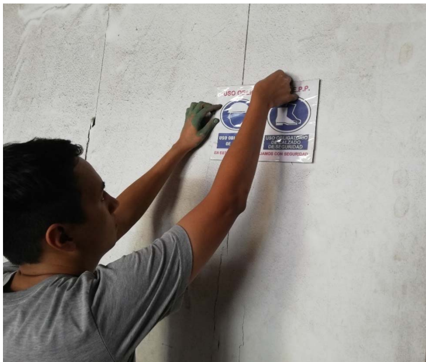
Figura 341. Evidencia fotográfica 5 de señalización de áreas Fuente: Elaboración de los autores.
