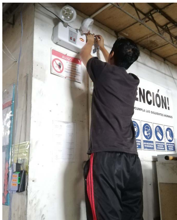
Figura 289. Instalación de huellero Fuente: Elaboración de los autores.
