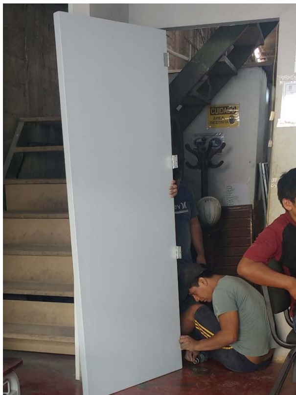
Figura 288. Instalación de puerta de oficina Fuente: Elaboración de los autores.
