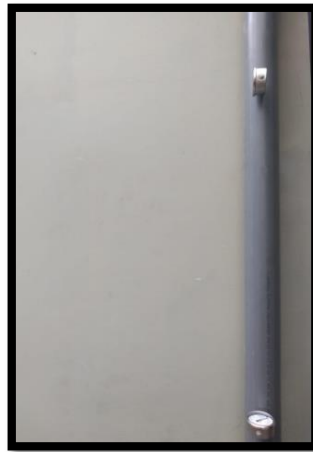
Figura 23. Instalación de válvulas y manómetros
