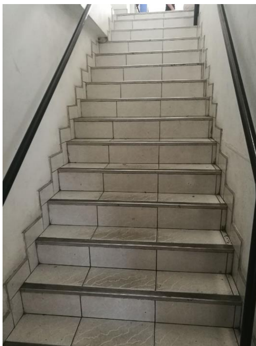
Figura 336. Escalera antes de la limpieza Elaborado por: los autores
