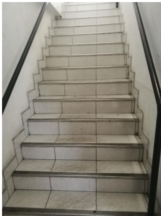
Figura 337. Escaleras después de la limpieza Elaborado por: los autores
