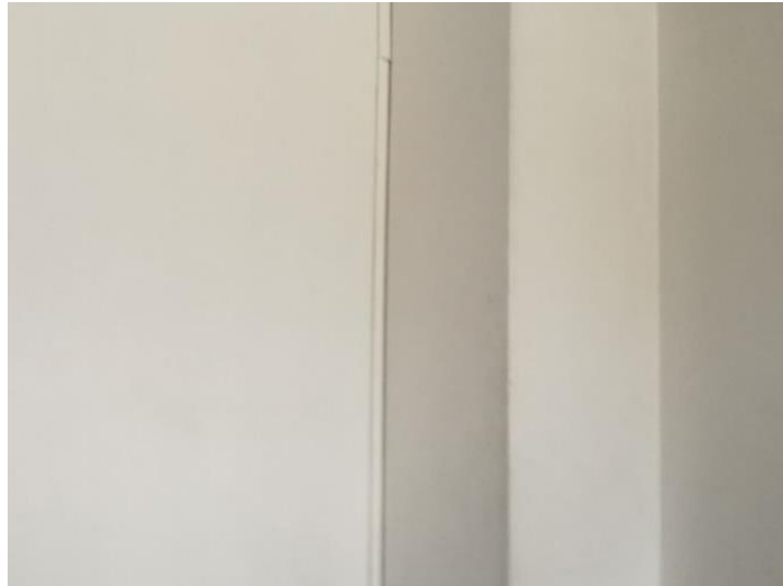
Figura 212. Área de acabados antes de Implementación Elaborado por: los autores
