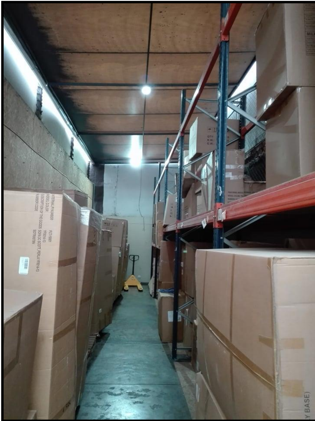
Fotografía 5. Implementación de techo de lona y estructura metálica, instalación del rack en extremo derecho e iluminación adecuada
