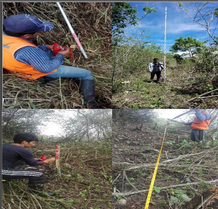
**Fotografía 08:** Se aprecia en la fotografía el levantamiento topográfico de carretera Santa Rosa-Puerto Churo.
