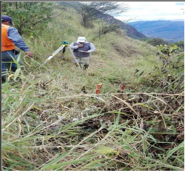
**Fotografía 07:** Se aprecia en la fotografía el levantamiento topográfico de carretera Santa Rosa-Puerto Churo.
