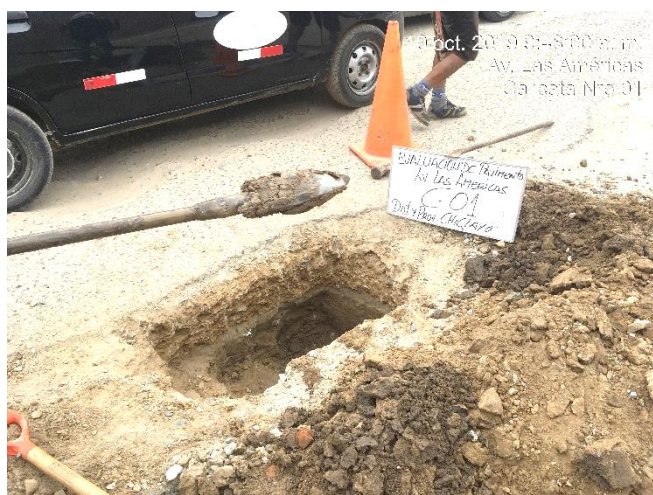
Figura N° 61. Calicata N° 01 realizada en la Av. Las Américas
