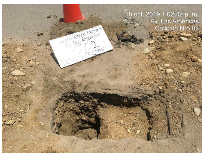
Figura N° 62. Calicata N° 02 realizada en la Av. Las Américas
