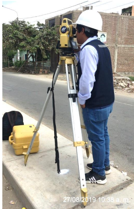
Fotografía N° 3. Lectura de puntos del Tramo 01 y 02 – Av. Las Américas
