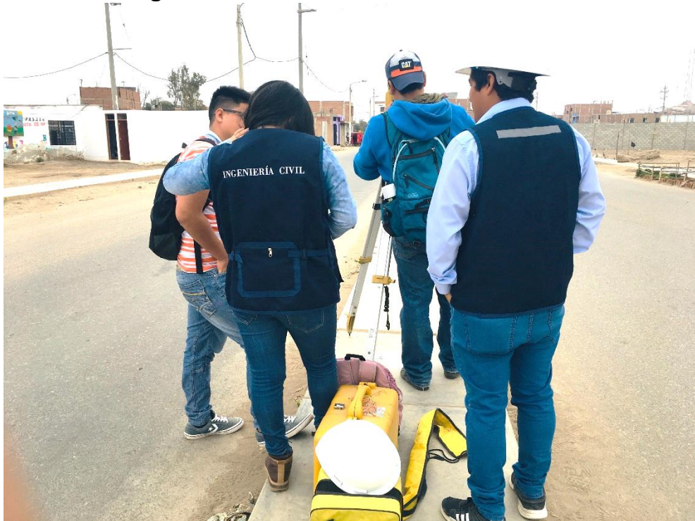
Fotografía N° 1. Instalación de la estación total
