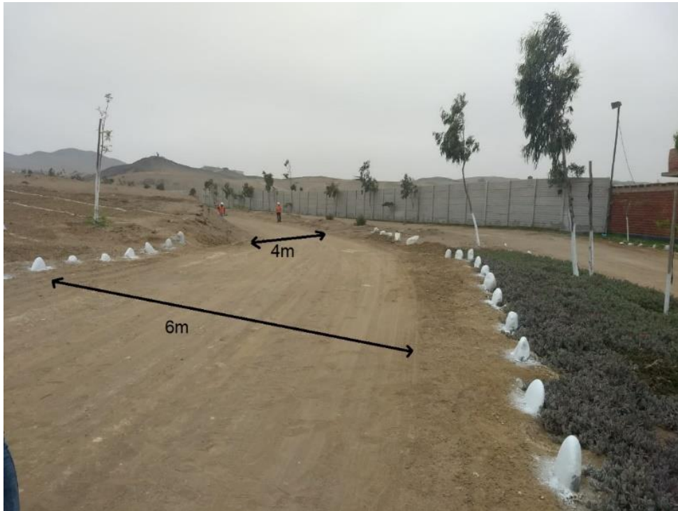
Figura N° 23 Cambio de sección en la calzada
