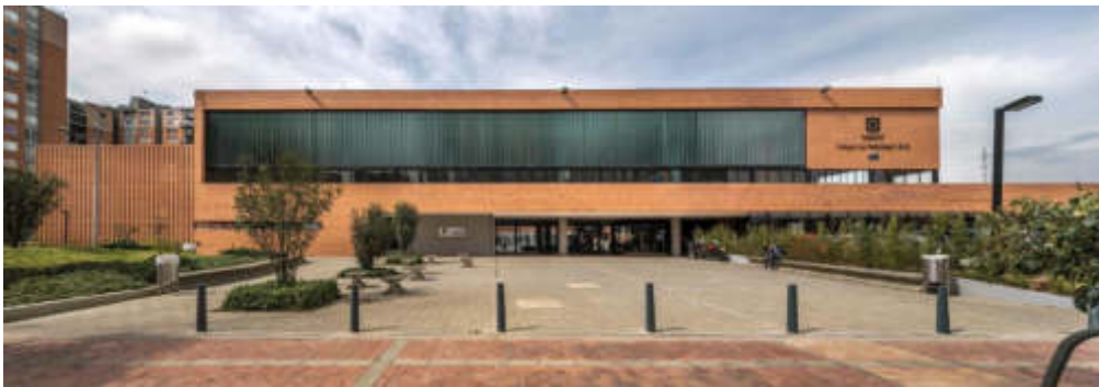
Figura N°20 y 21: Fachada principal de mampostería del colegio
