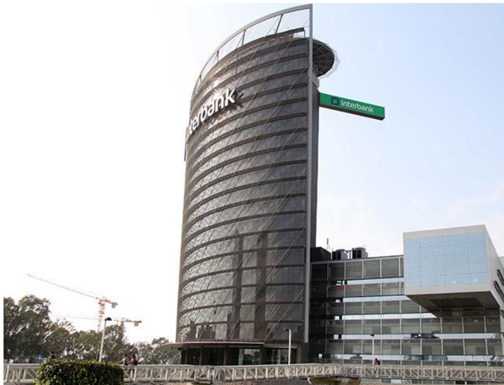
Figura 5. Banco Interbank- Sede La Victoria.
