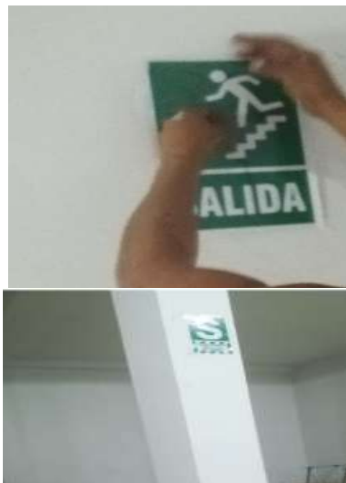
Figura HHHH21. Áreas con señalizaciones
