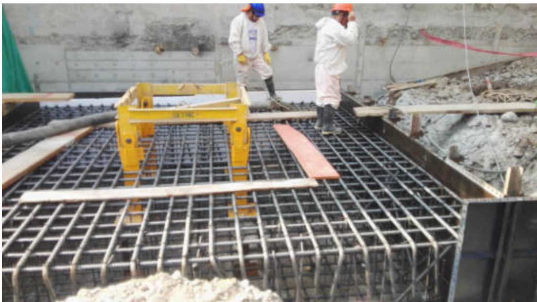
Fotografía 2. Encofrado de Zapata de Grúa
