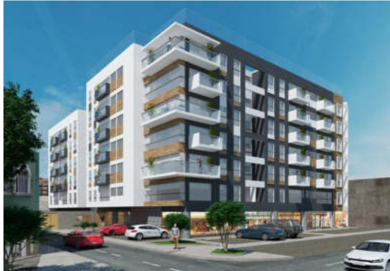
Figura 18. Edificio multifamiliar Leaf
