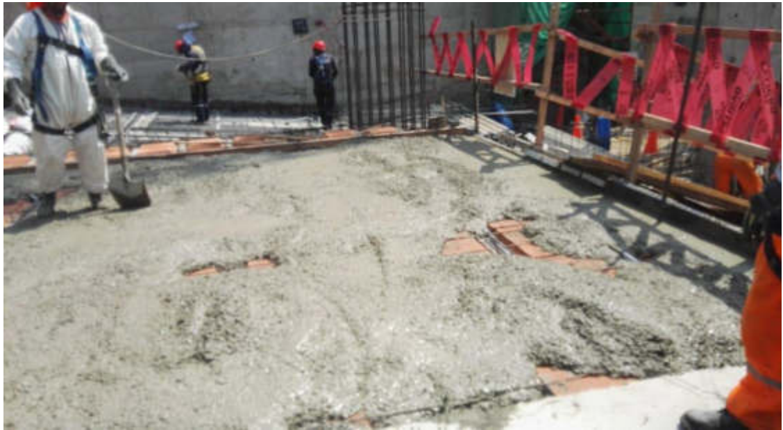
Fotografía 3. Vaciado de losa sótano 1
