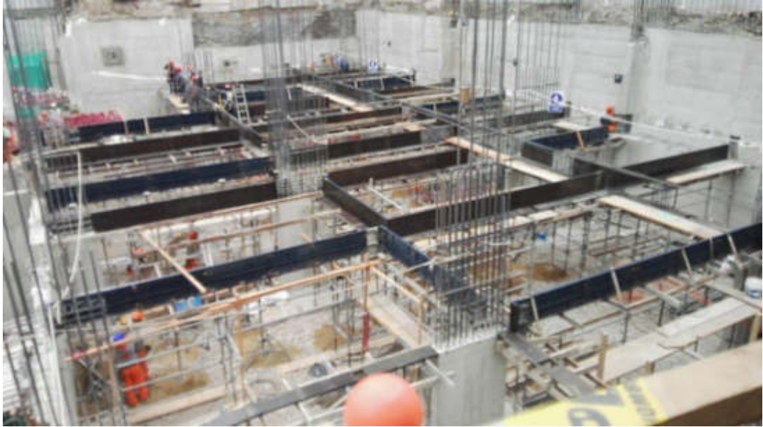
Fotografía 1. Encofrado de vigas sótano
