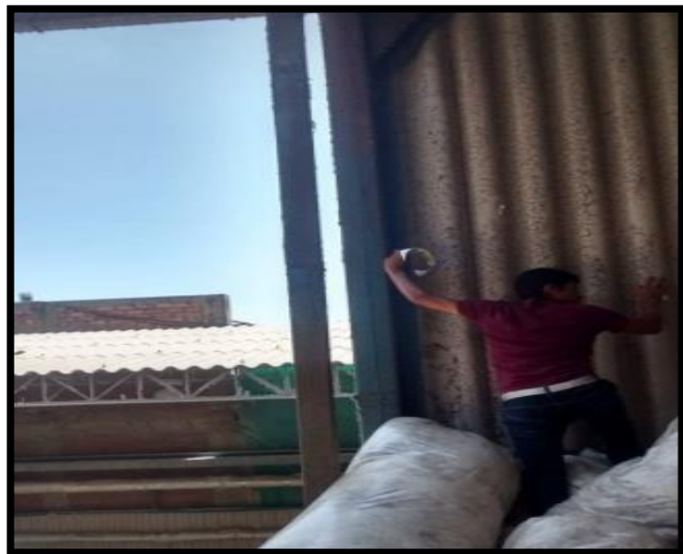
Figura 174. Colocación de señalización de seguridad industrial
