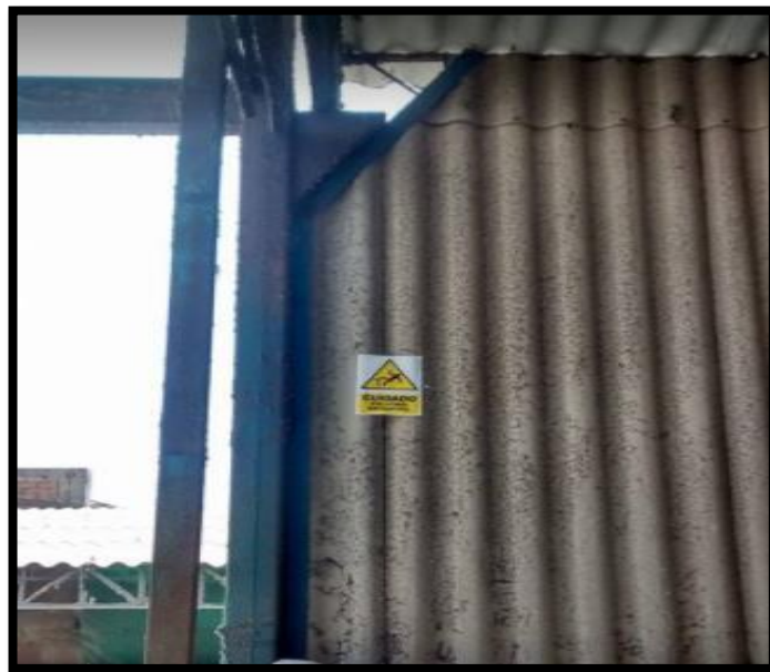
Figura 176. Colocación de señalización de seguridad industrial
