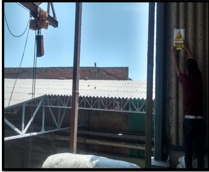
Figura 175. Colocación de señalización de seguridad industrial
