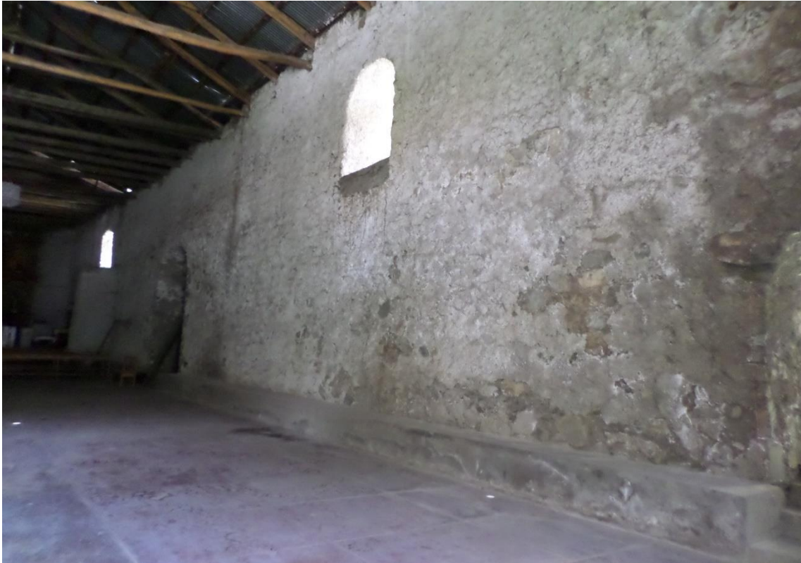
Imagen 119. Se aprecia la parte interna del muro de la iglesia que fue salpicado con cemento y pintada con yeso blanco. Fuente. Archivo personal. Foto tomada el 26 de julio de 2017.
