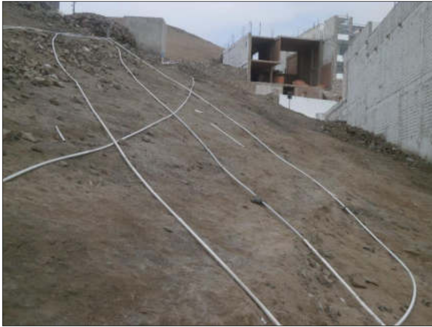
Ramales expuestos de tuberías
