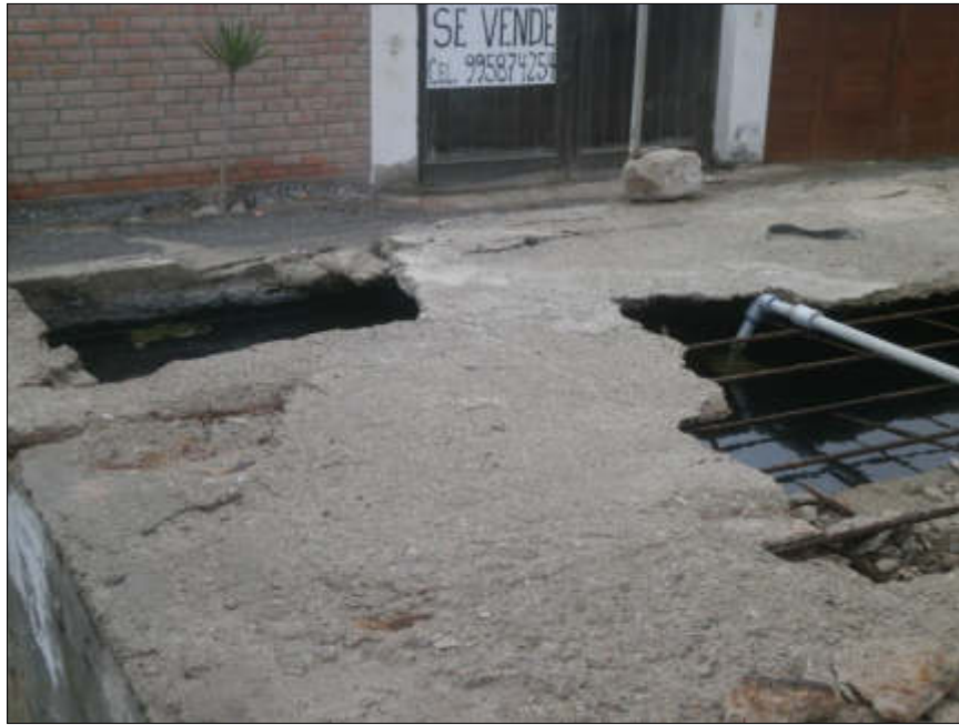
Tanques de agua en mal estado
