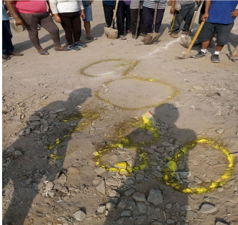
Foto 3. Marcando código de calicata y profundidad de excavación.
