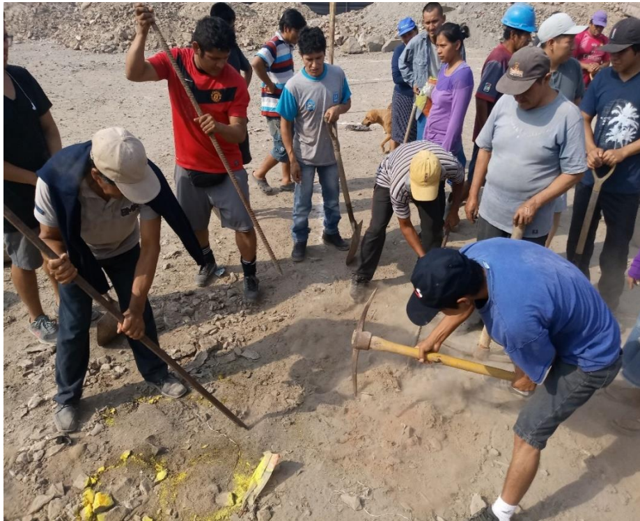
Foto 5: Inicio de excavación
