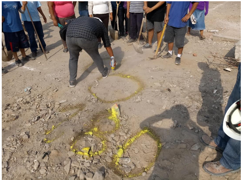
Foto 4 Marcado de calicata
