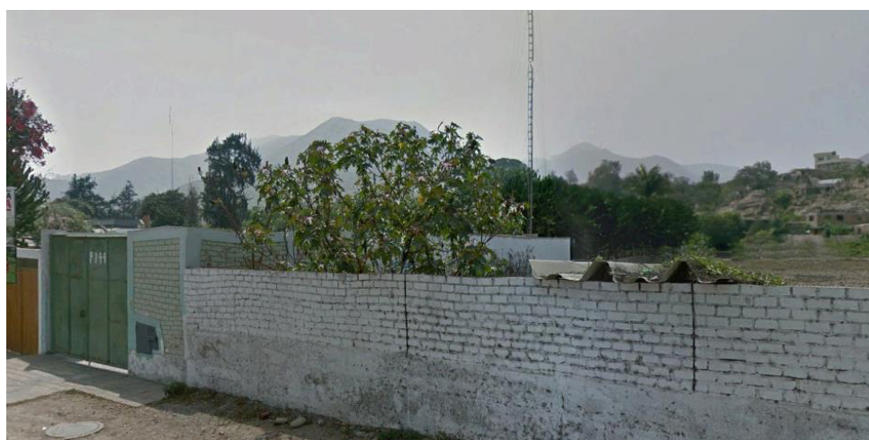
Imagen N°26: Vista del pozo de extracción de agua
