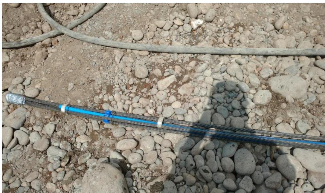
*Figura 14.* Instalación del anclaje
