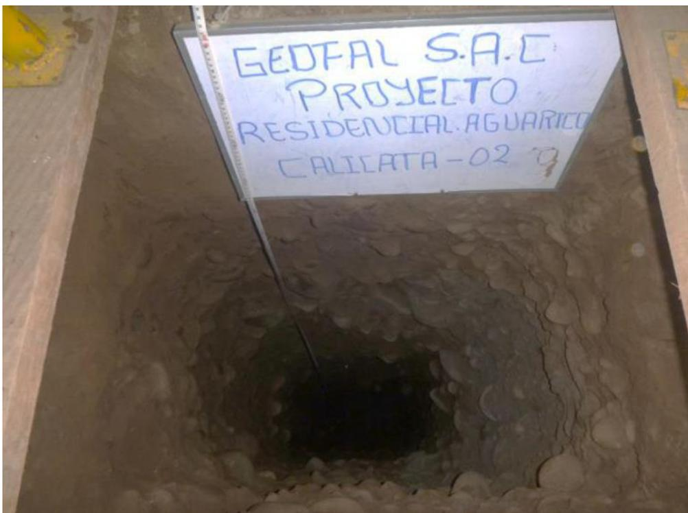
[Fotografía de calicata C-2]. (Excavación de la calicata C-2 para obtener las muestras).
