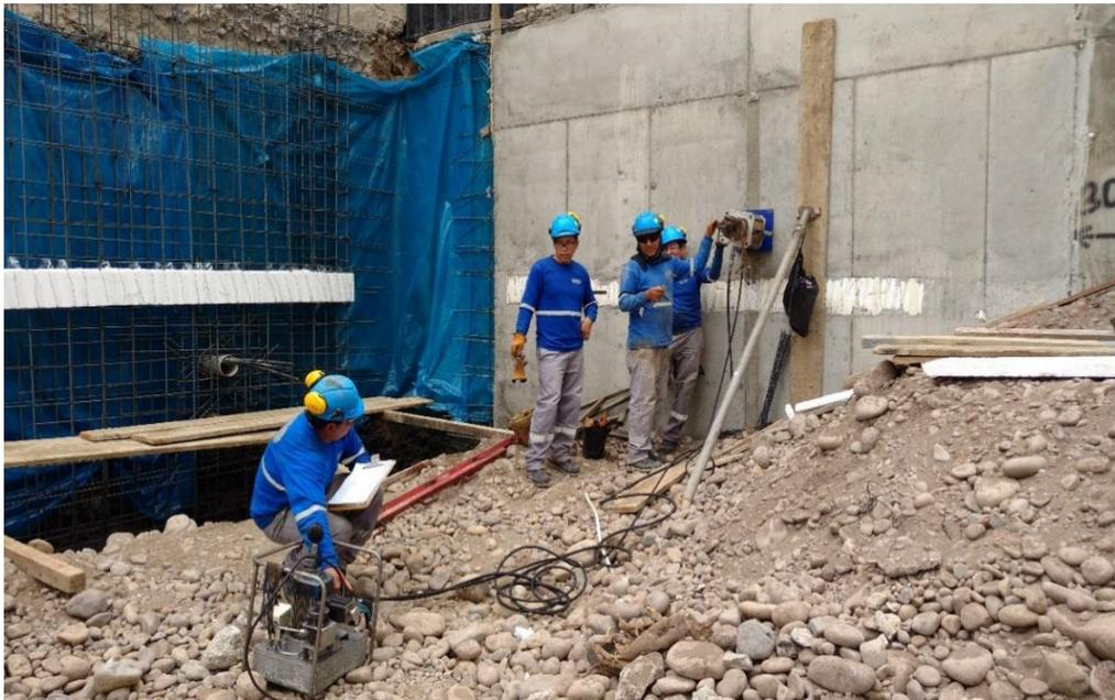
*Figura 20.* Tensado del anclaje
