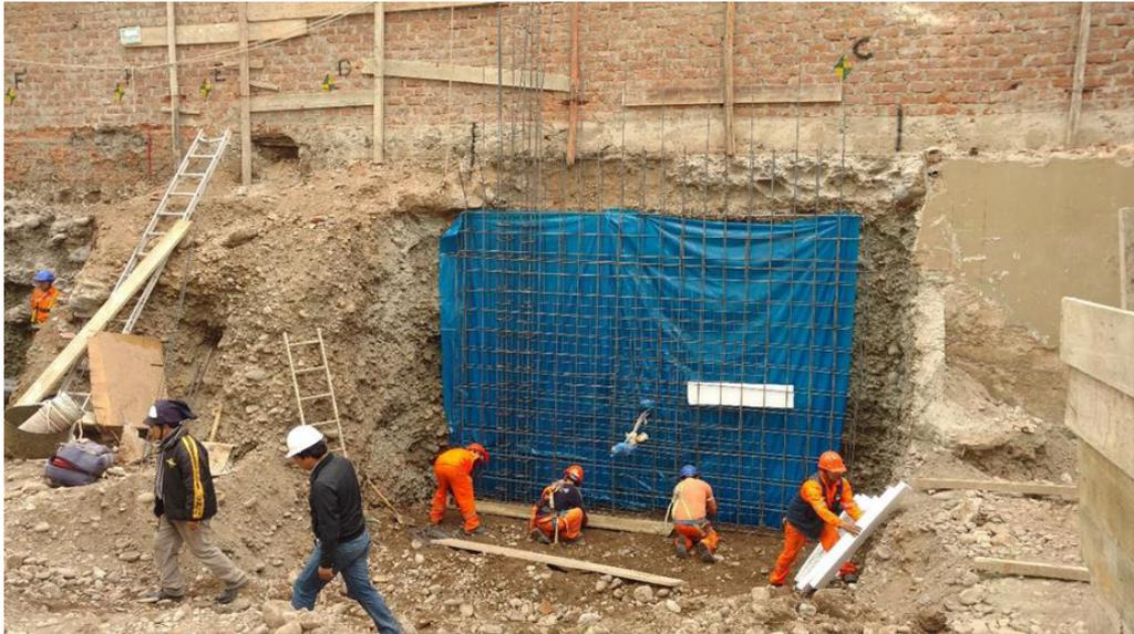
Figura 15. Habilitación y colocación del acero de refuerzo
