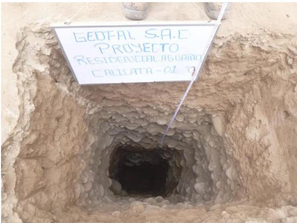
[Fotografía de calicata C-1]. (Excavación de la calicata C-1 para obtener las muestras).
