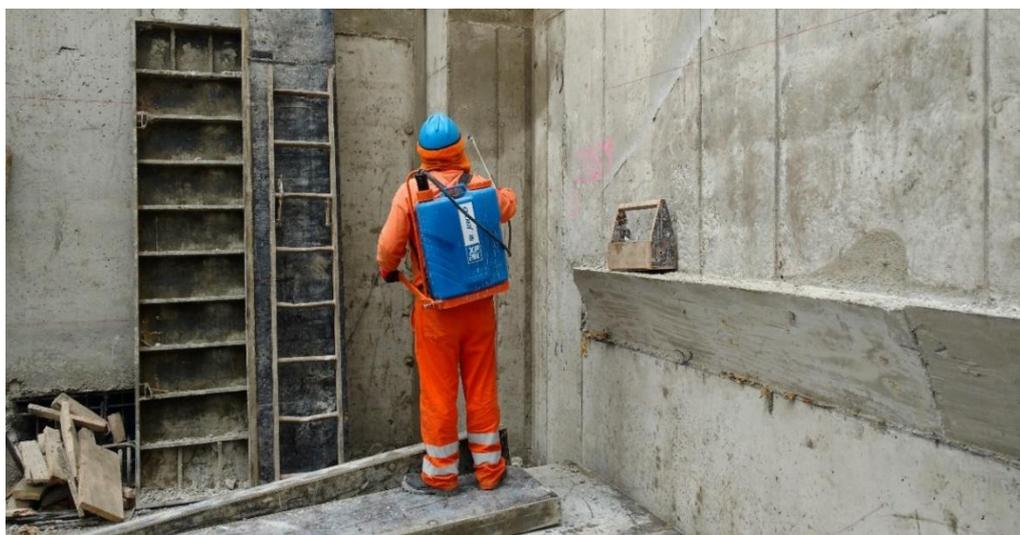
*Figura 18.* Curado y protección del concreto
