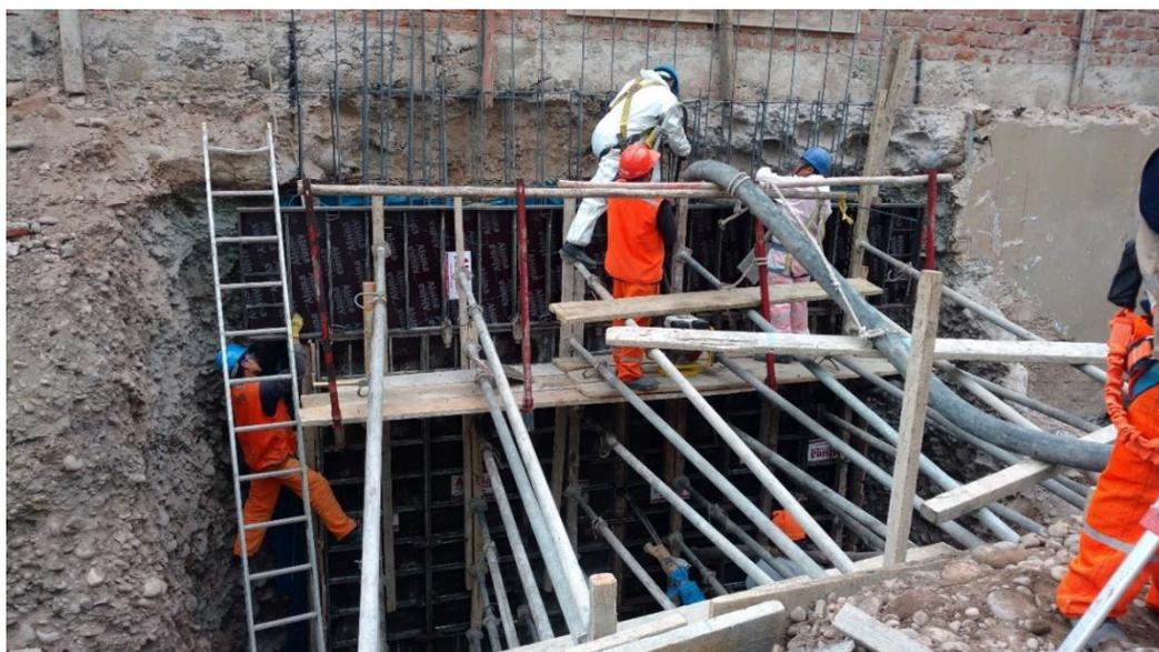
*Figura 17.* Colocación de concreto
