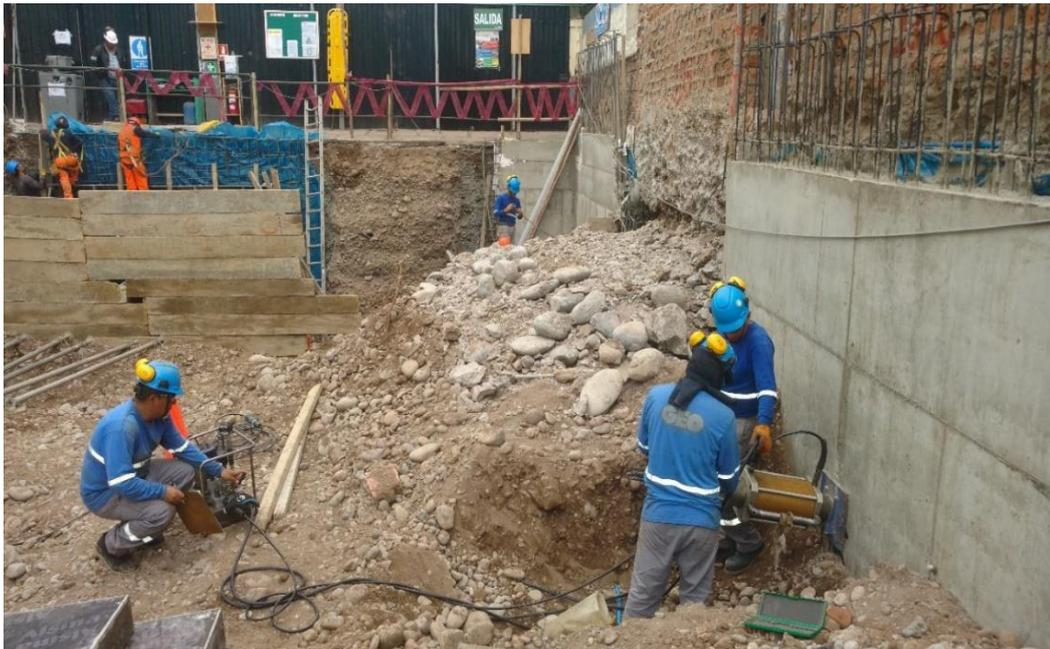
Figura 19. Tensionamiento
