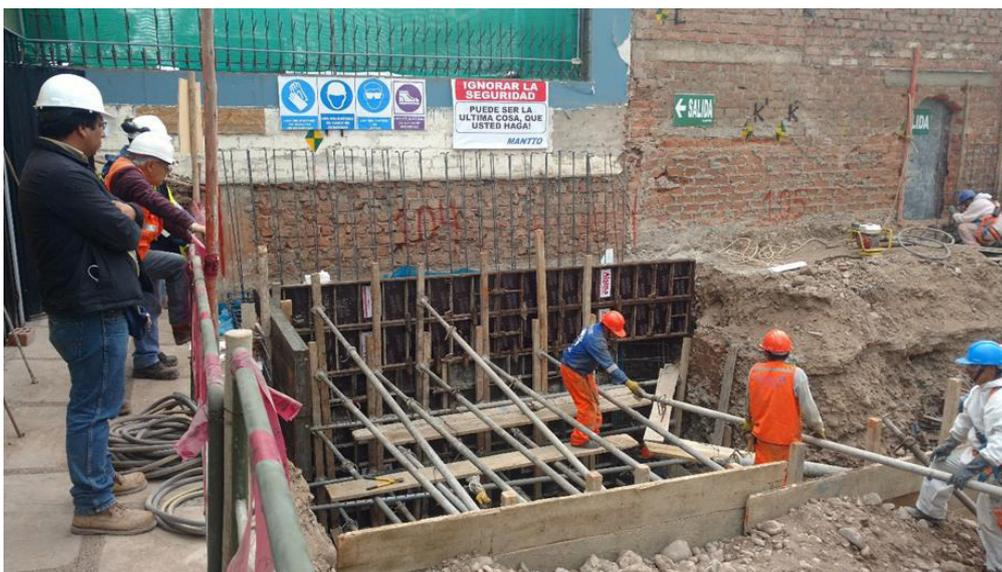
Figura 16. Habilitación y encofrado de los muros
