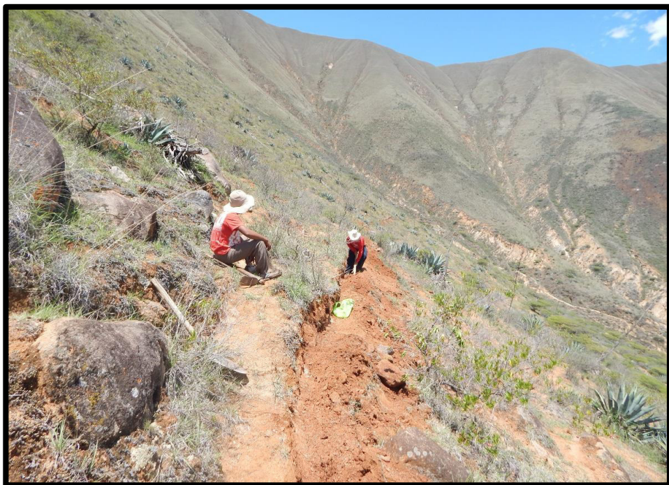
Excavación para instalación de tubería hdpe
