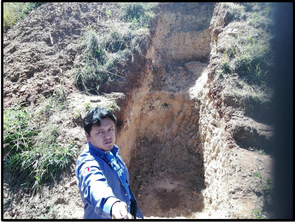
Excavación para instalación de pase aéreo
