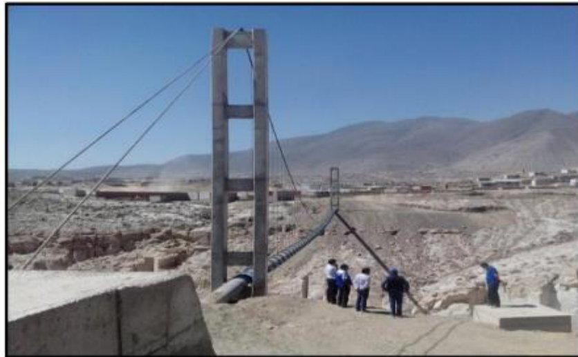
FIGURA 1 : Pase aéreo para colectores principales de desagüe Yura - Arequipa
