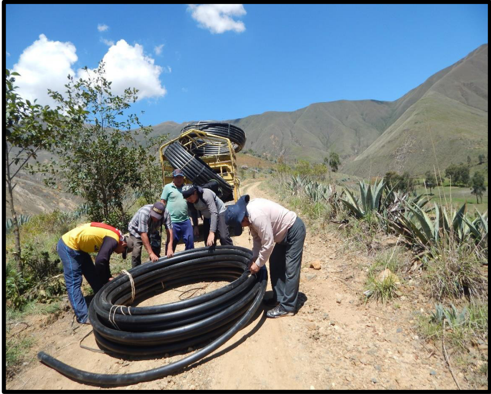
Transporte de tubería hdpe en Huánuco
