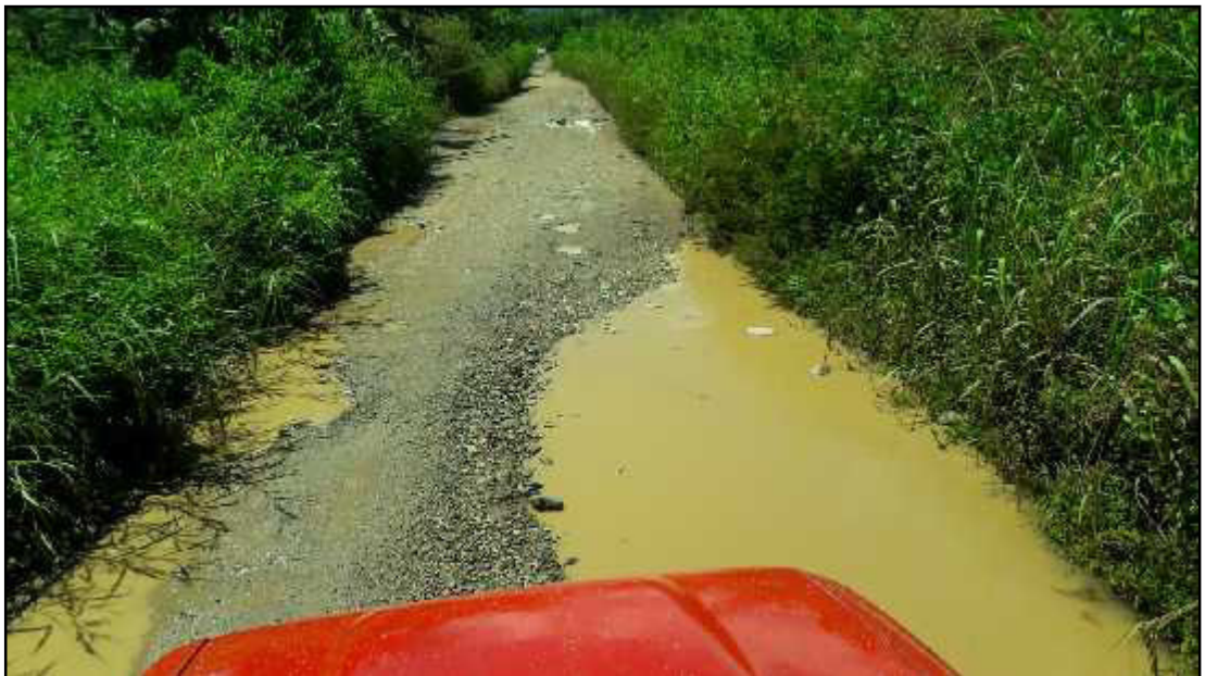
Falta de señalización
