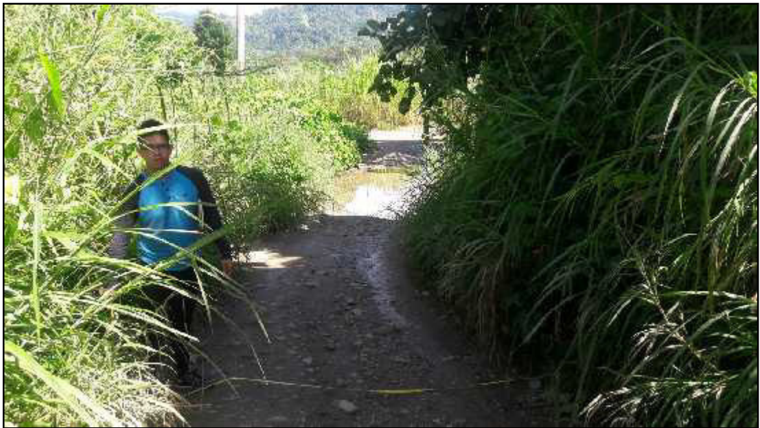
Vía invadida por la maleza a falta de mantenimiento
