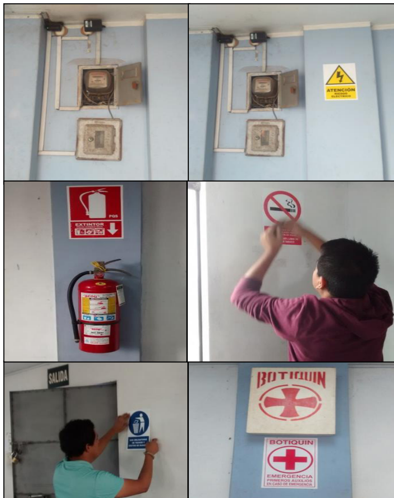
Figura 70. Colocación de señalética para identificación de peligros y señalética en general
